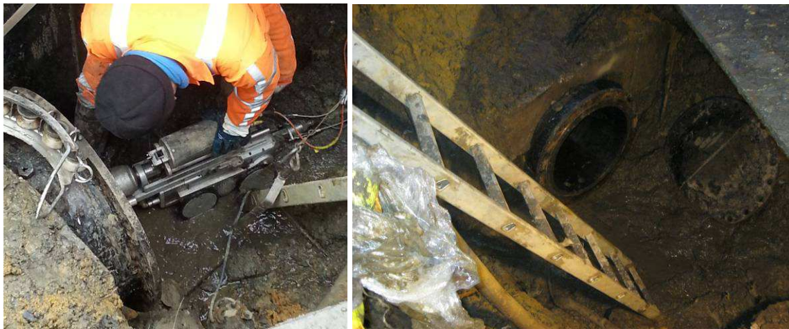
Bild 1 Einführung des Kanalradars in die zu prüfende Strecke (links), Öffnung der Haltung (rechts)
