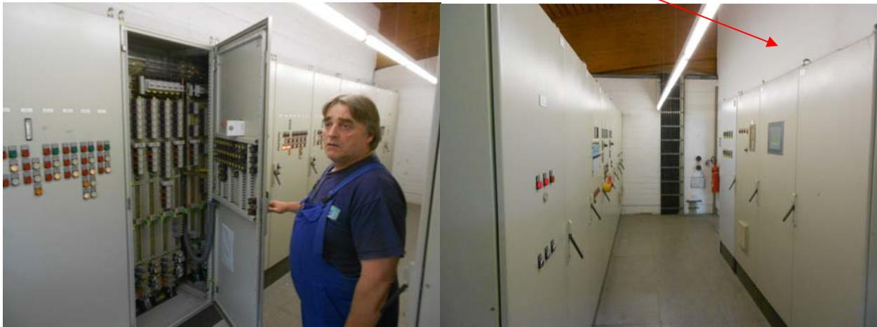
Abbildung 4-5 Schaltanlage der Sandfiltration/ mit einem neuen Schaltschrank/ Siemens S7
