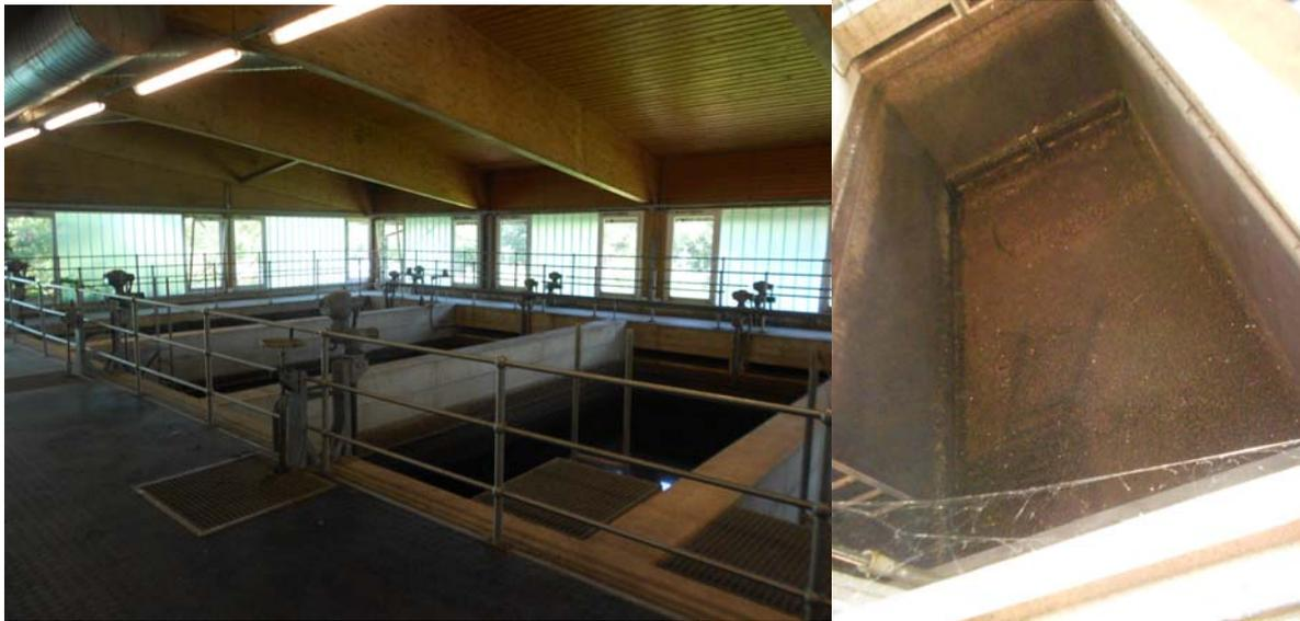
Abbildung 4-3 Sandfilteranlage einzelne Kammern/ leere Kammer/ Rohrkeller
