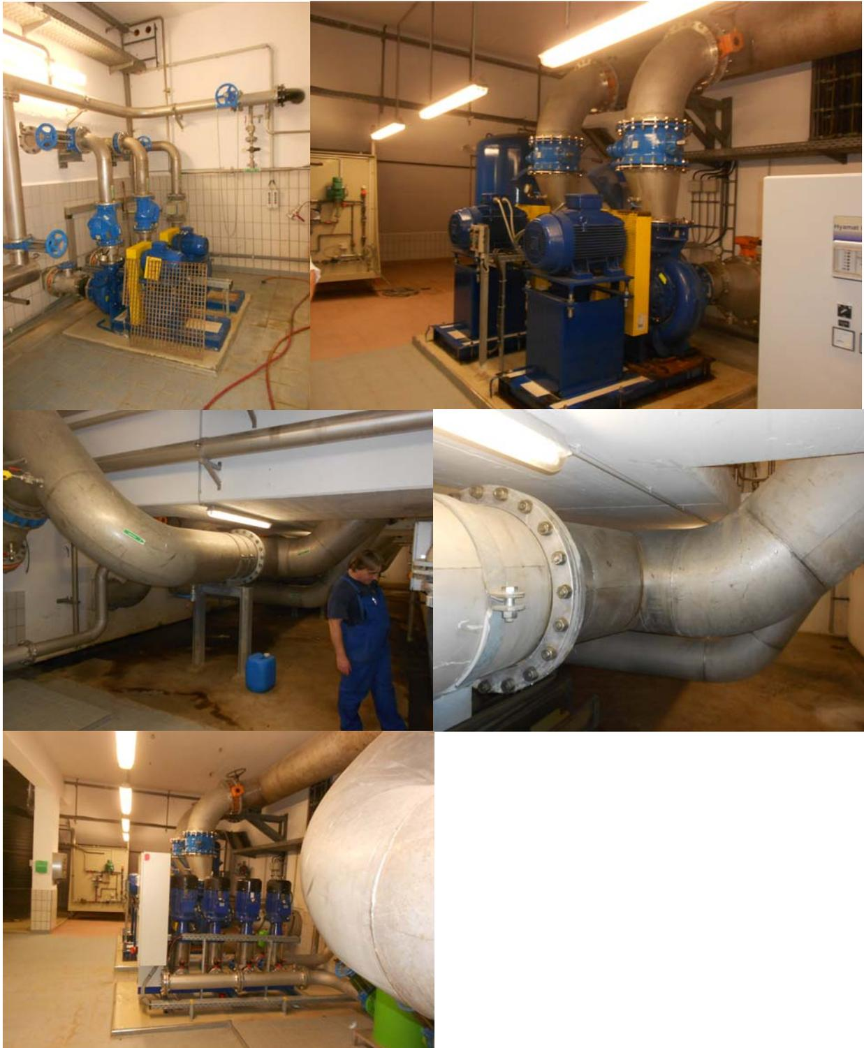
Abbildung 4-4 Verrohrung der Sandfilteranlage Luft/Wasser-Rückspülung/ Brauchwasseranlage
