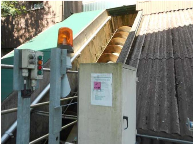
Abbildung 4-6 Hebeschnecken Sandfilteranlage/ Dosieranlage Eisensalz/ Polymer
