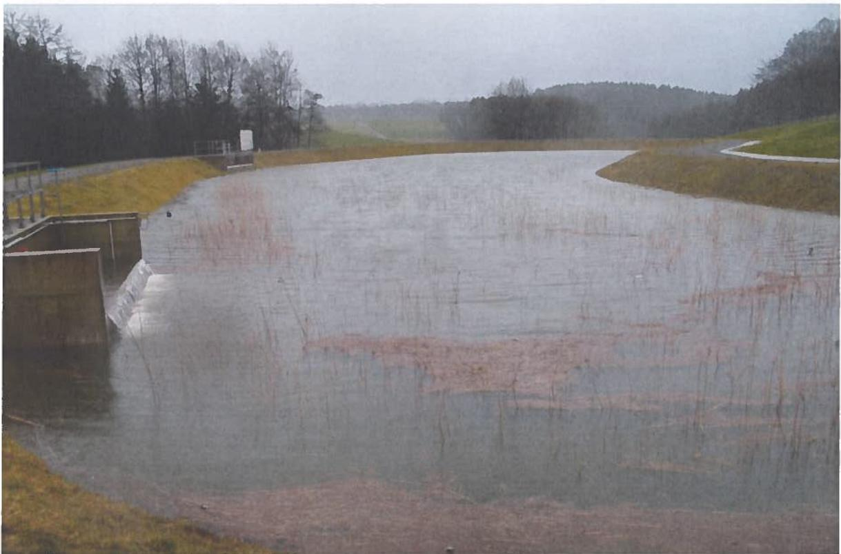
**Abbildung 3: Bodenfilter Heilkuhlbach – Stand Januar 2007, Einstauereignis**
