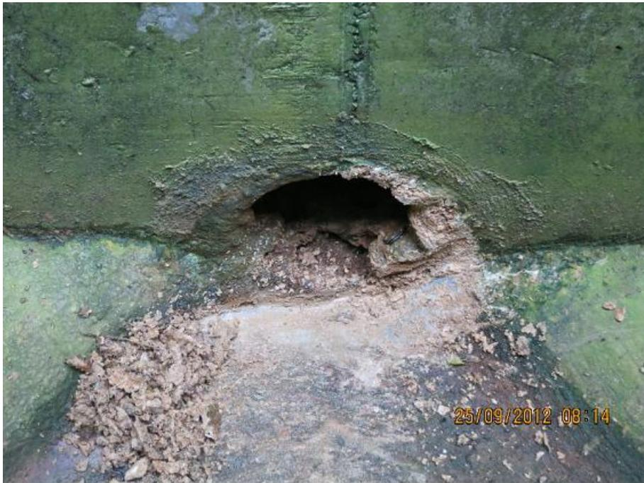
Bild 8-18: Carbonatausfällung im Dränablaufschacht (RBF Buchen) ist im Vergleich zu Mangan- und Eisenausfällung selten. Die Ausfällung kann hohe Schwermetallgehalte u.a. Zink enthalten. Der Überschuss an CO<sub>2</sub> bzw. die Carbonatausfällung im Dränablauf kann u.a. durch Filtereinstau und sehr geringe hydraulische Belastung verursacht sein.
