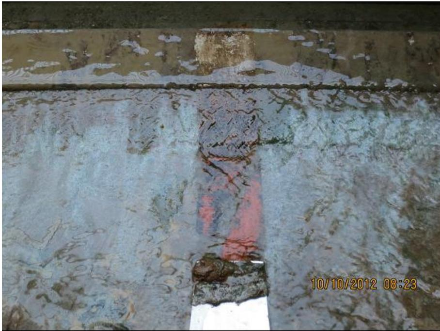
Bild 8-17: Der unvollständige Abbau der gelösten, organischen Substanz ist an der Überlaufschwelle des Dränablaufes (hoher Teileinstau) durch den grauen Biofilm erkennbar.
