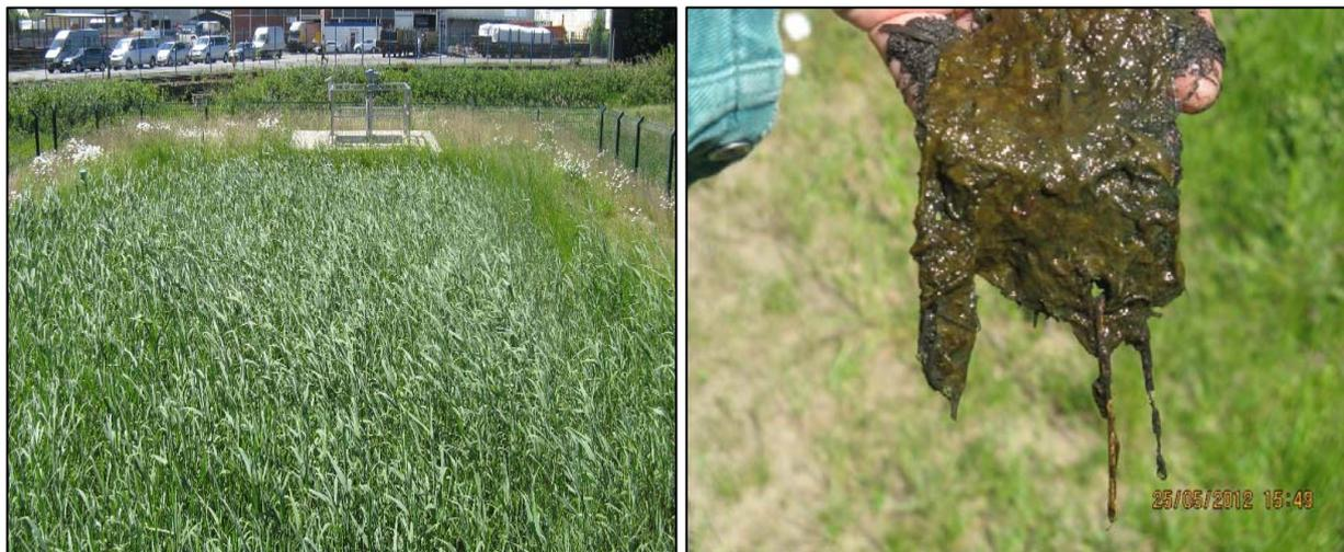
Bild 5-22: Kolmation zu Betriebsbeginn bei üblicher Feinpartikelbelastung ( $4 \text{ kg TM}_{T+U}/\text{m}^2_{AF} \cdot \text{a}$ ), RBF Bentelerstraße, Trennsystem. Fehlende Althalme zeigen die Schilfernte an (links). Der Einstau des Sedimentes führt zu einer hydraulisch undurchlässigen Algengallerte (rechts)
