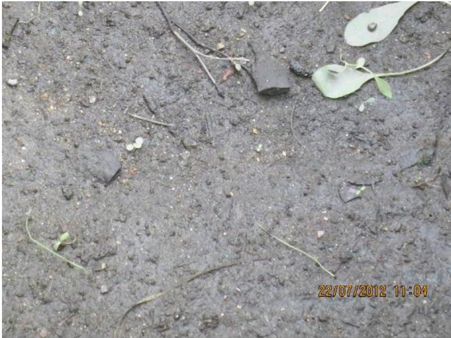
Bild 8-15: Filter die lange eingestaut sind, zeigen auch bei hohem Grobkornanteil des Sedimentes keine Poren auf der Filter- bzw. Sedimentoberfläche. Oberfläche von stark mit Straßenfeststoffen belastetem, unbepflanztem Rinnenfilter.
