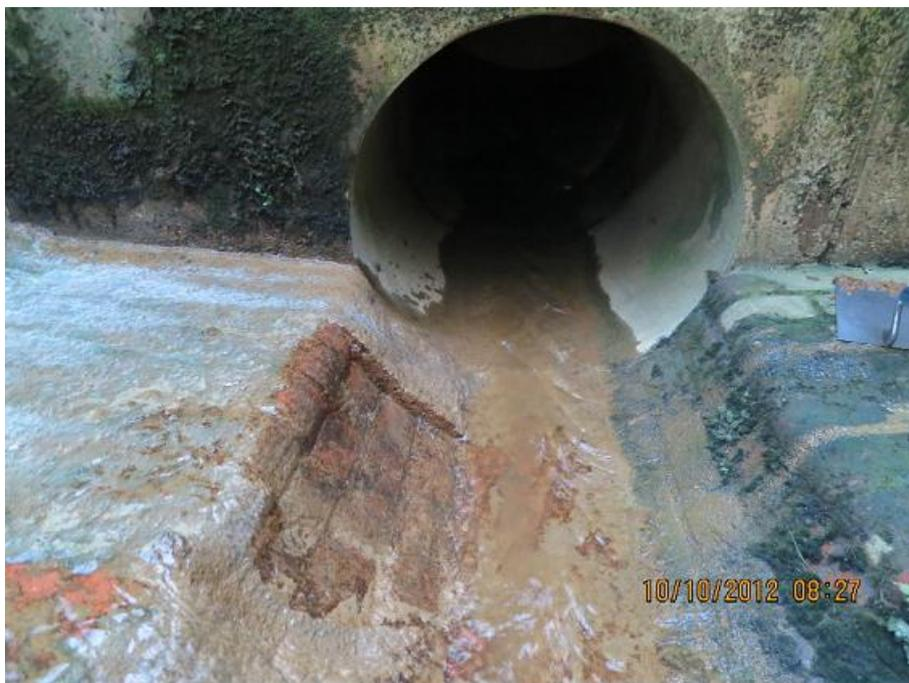
Bild 8-20: Der hohe permanente Einstau des Filters bis in die Sedimentschicht führt zur Eisenrücklösung, die teilweise im Ablaufschacht als Ockererz wieder ausfällt.
