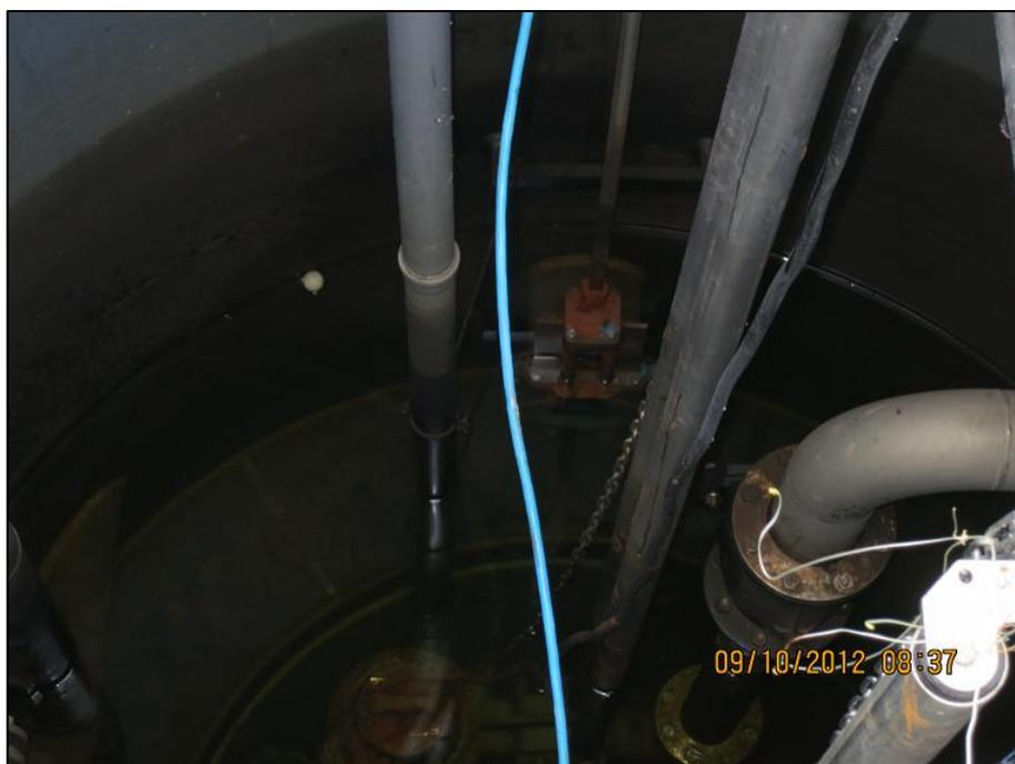
Bild 5-28: RBF-Altendorf. Blick in den Dränablaufschacht. Der dortige Teileinstau verursachte nur eine Manganfreisetzung aus dem sandigen Filtermaterial (schwarzer Wandbelag)
