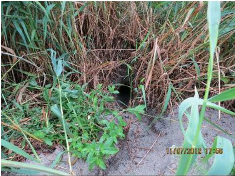
Bild 8-3: Große Tierhöhlungen sind ein Zeichen sehr geringer Beschickungshäufigkeit. Bei den meisten Anlagen mit Tierhöhlungen sind diese zulauffern anzutreffen, was nicht nur auf eine geringe feinpartikuläre, sondern auch auf eine hydraulische Belastung dieses Filterteiles hinweist. RBF Kenten.
