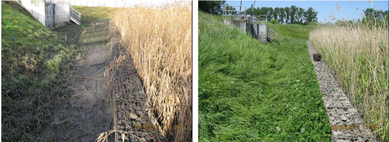
Bild 5-3: RBF-Kenten, Zulaufbereich. Die auch zulaufnah nur selten hohe Feinpartikelbelastung kann an der üppigen Vegetation der Zulaufpflasterung (rechts, 26.05.2012) nach einer hohen Feinpartikelfracht (links, 24.12.2011) erkannt werden
