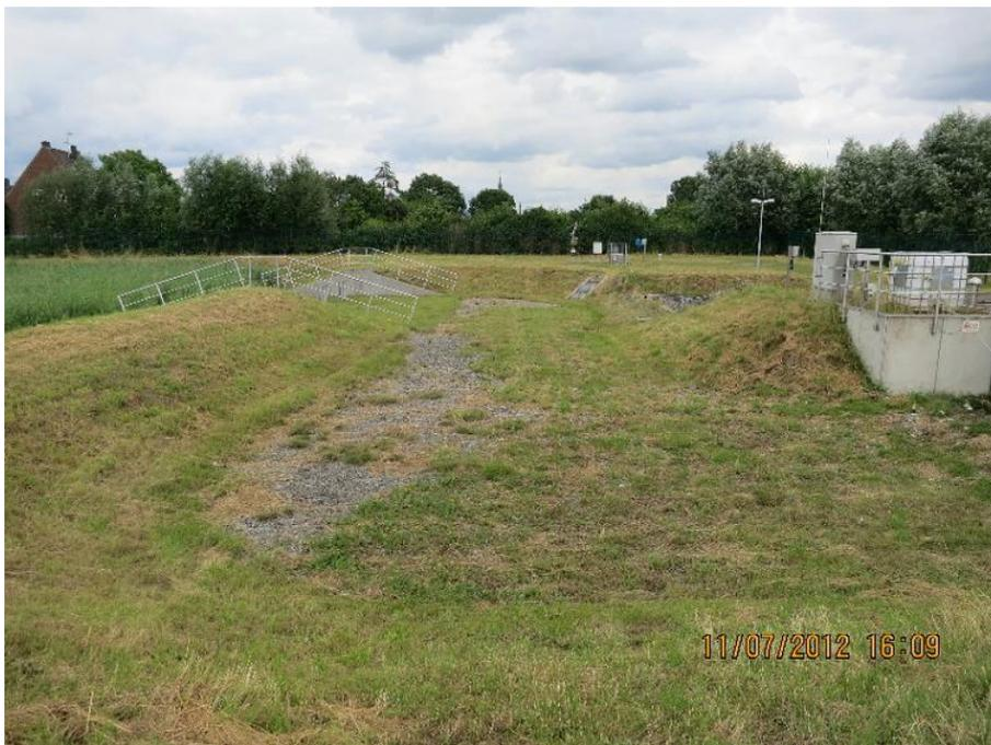
Bild 5-4: Die besonders große Sedimentationsfläche vor der Filterfläche des RBF Vanikum minderte die auf der Filterfläche ermittelte Feinpartikelbelastung
