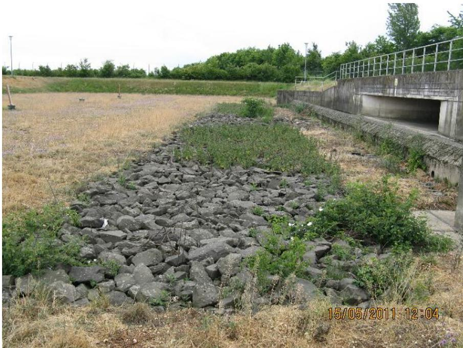
Bild 5-2: Magerer Brennesselbestand auf der Filtervorfläche des 13-jährigen RBF Elsdorf zeigt die sehr geringe Feststoffbelastung an
