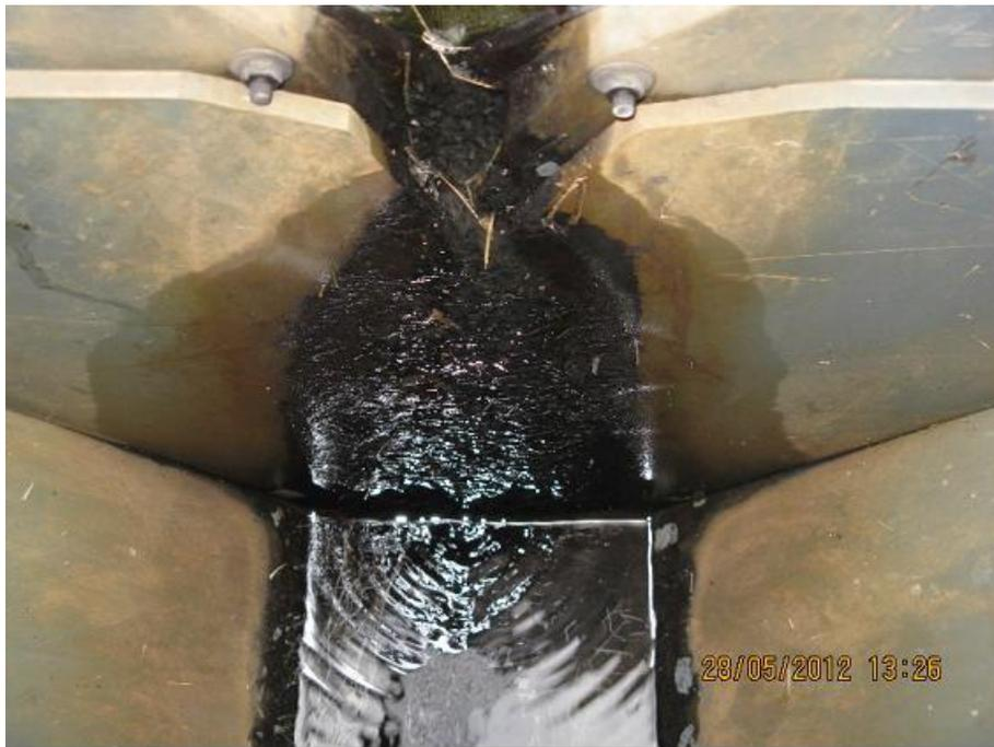
Bild 8-19: Die tief schwarze Ausfällung am Dränablauf des RBF Fellenweg zeigt an, dass Mangan gegenüber Eisenausfällung dominiert. Die Dominanz der Manganausfällung zeigt gegenüber der des Eisens ein geringeres Sauerstoffdefizit im Filter an.
