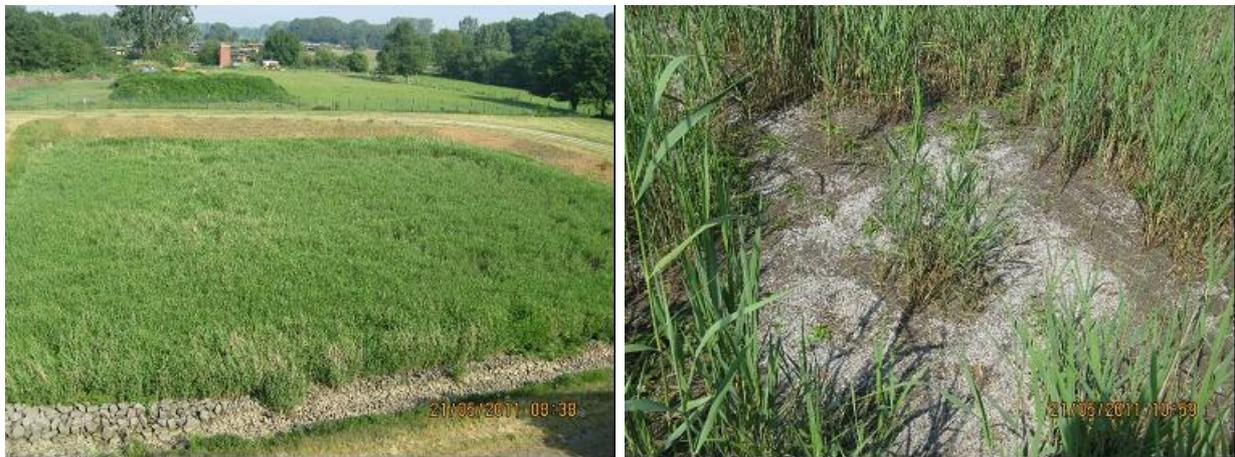
Bild 5-17:RBF Harwick, Eine geringe Feinpartikelbelastung ( $\bar{\varnothing}$  0,51 kg T+U/m<sup>2</sup>\*a) und eine quadratische Beetform führt zu sehr ungleicher Belastung der Filterfläche.
