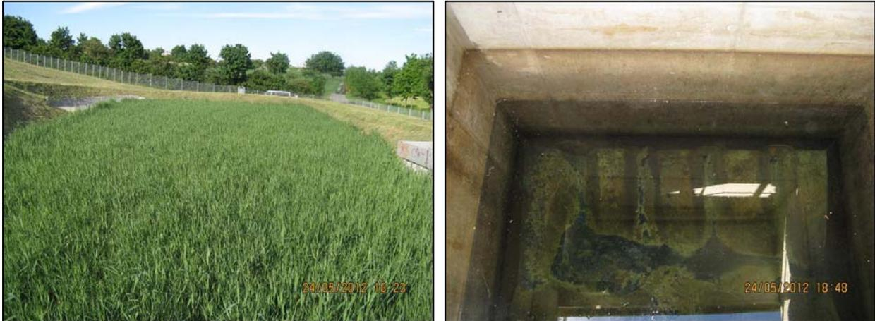
Bild 5-24:RBF-Benhausen, 4. Betriebsjahr, 24.05.2012. Trotz der geringen Filterbelastung ist durch den Teileinstau (rechte Bildhälfte, Dränablaufschacht) der Schilfbestand geschlossen (linke Bildhälfte)
