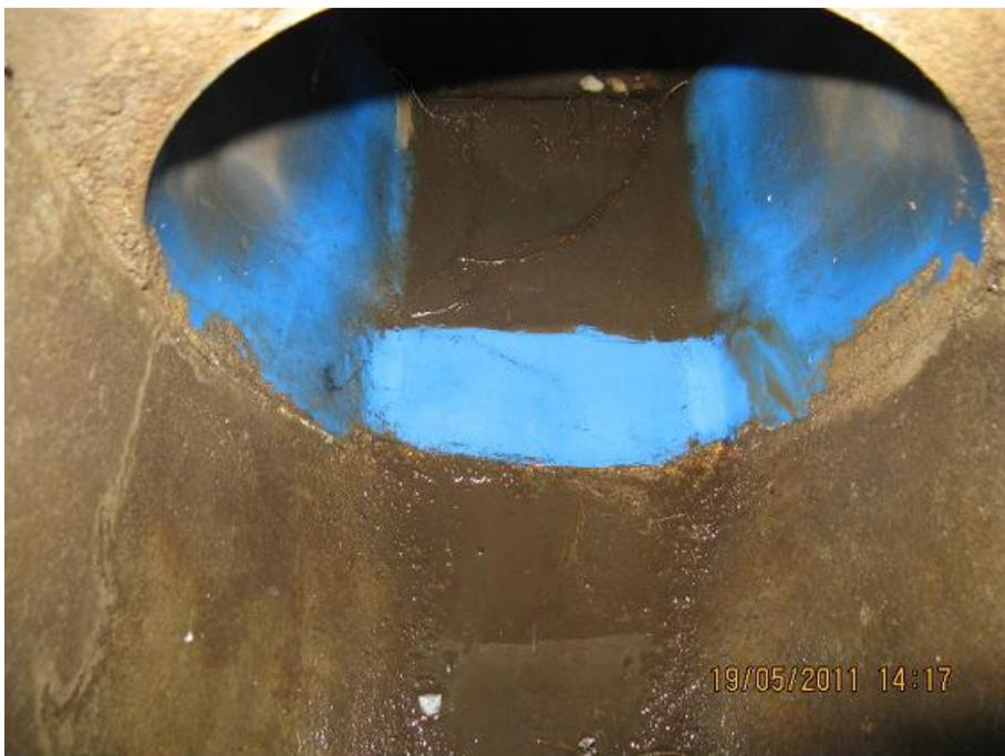
Bild 8-16: Bei Filtern, die ein sehr grobes Filtersubstrat besitzen (hoher Kiesanteil) oder Kurzschlüssigkeit durch Höhlungen bis zur Dränschicht, kann es zum Feinpartikeldurchbruch kommen.
