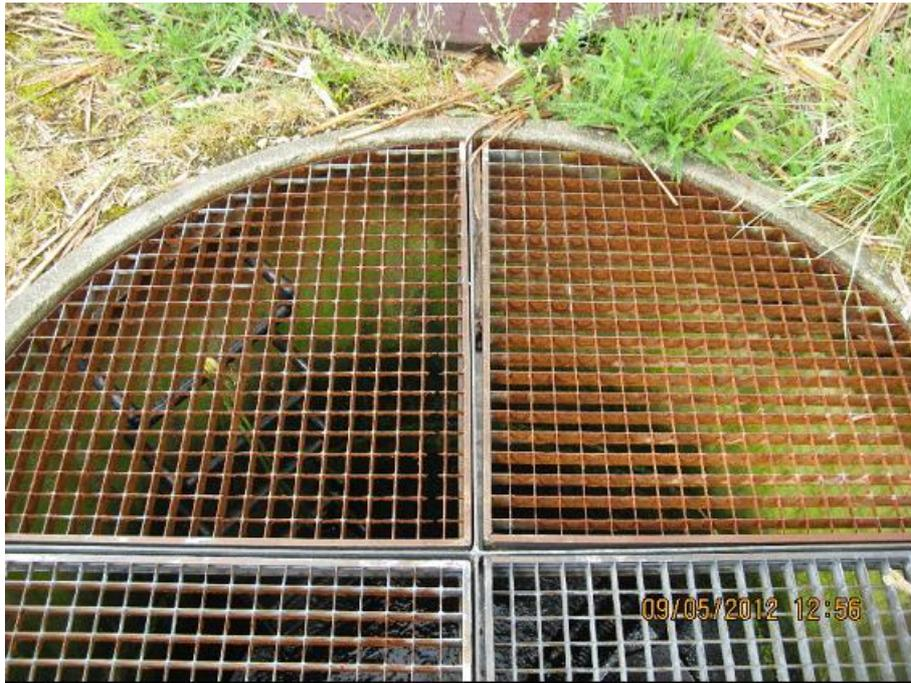
Bild 8-21: Bei sehr hohem Sauerstoffdefizit im Filter, z.B. verursacht durch permanenten Teileinstau, kommt es im Filter zur Sulfatatmung. Das gebildete  $H_2S$  gas am Ablaufschacht aus und oxidiert zu Schwefelsäure, die die Abdeckung des Ablaufschachtes korrodiert.
