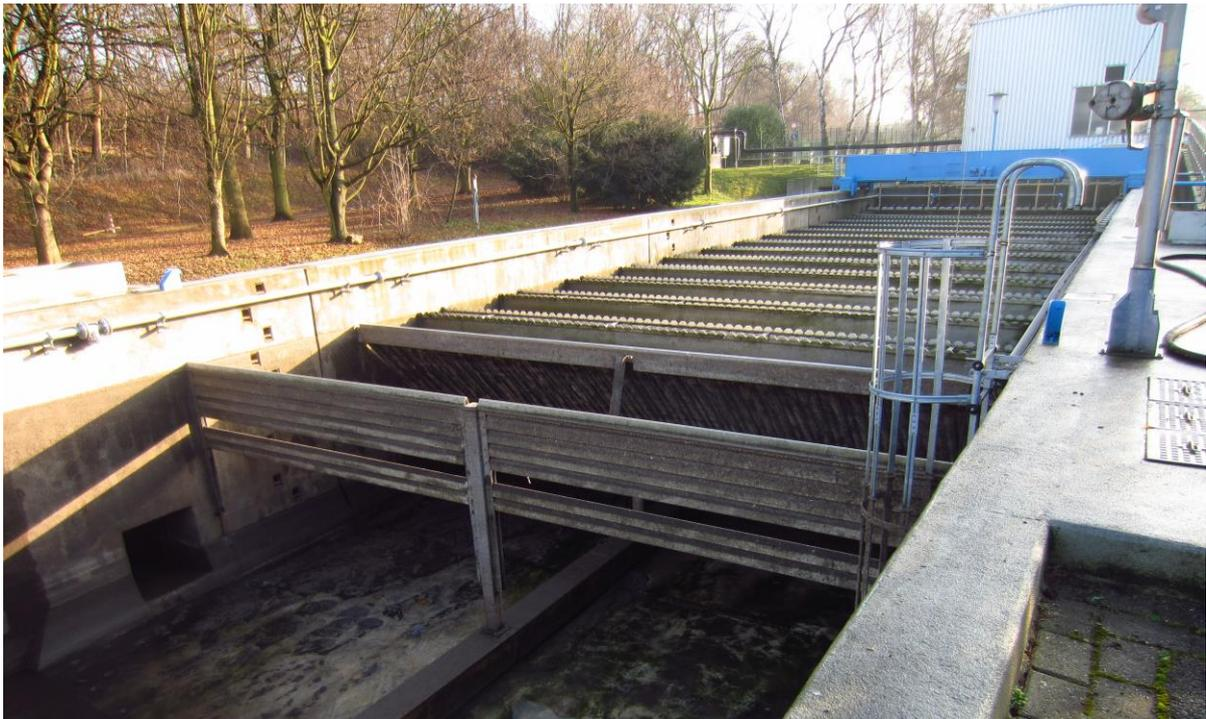
Abbildung 2: Lamellenabscheider in RÜB II
