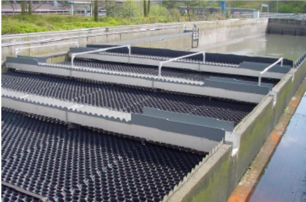
**Bild 2.4:** Installation der Versuchsanlage in dem zu untersuchenden Regenüberlaufbecken [DOHMANN et al., 2003]
