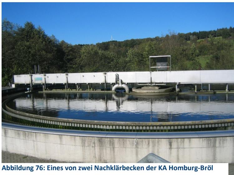
Abbildung 76: Eines von zwei Nachklärbecken der KA Homburg-Bröl
