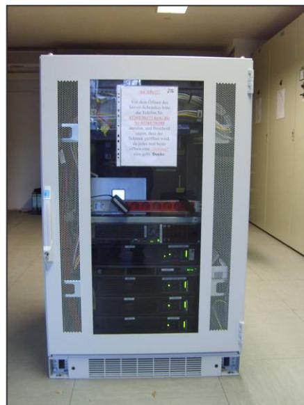
Abbildung 145: Serverschrank mit Regler- und Daten-PC
