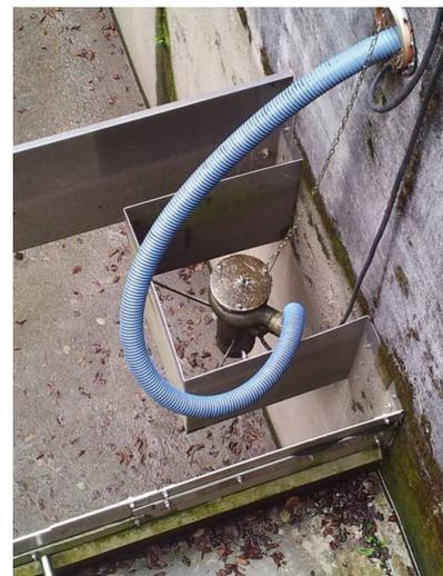
Abbildung 53: Entlastungspumpe RÜB Kalkofen
