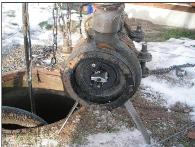
**Abbildung 52: Ablaufpumpe mit Schneidwerk**
