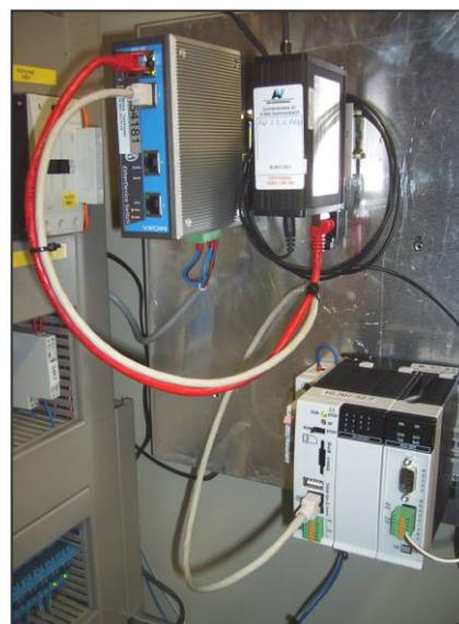
**Abbildung 143: Schaltschrank RÜB Talstraße mit GPRS-/UMTS-Komponenten**      **Abbildung 144: Schaltschrank innen**
