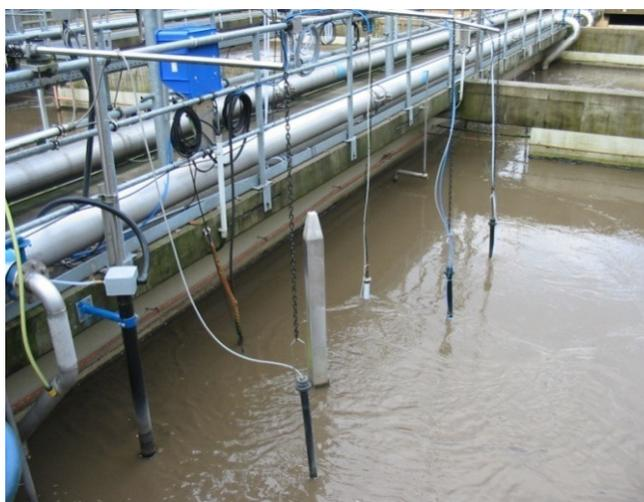
Abbildung 27: Messsysteme im Test in einem Belebungsbecken
