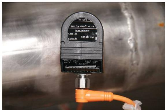
Abbildung 23a+b: Näherungssensor (links) und Strömungswächter (rechts)
