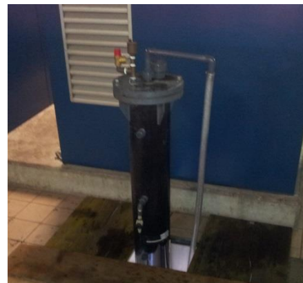
Abbildung 9: In der Vorhalle (links) aufgestellte Filtersäule (Kleinsorbent KA) mit einer Deckendurchführung in die obere Gebläsehalle (rechts)
