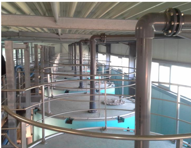
Abbildung 3: Blick auf eine der beiden Filterstraßen (je 7 Einzelfilter) der Flockungsfiltration
