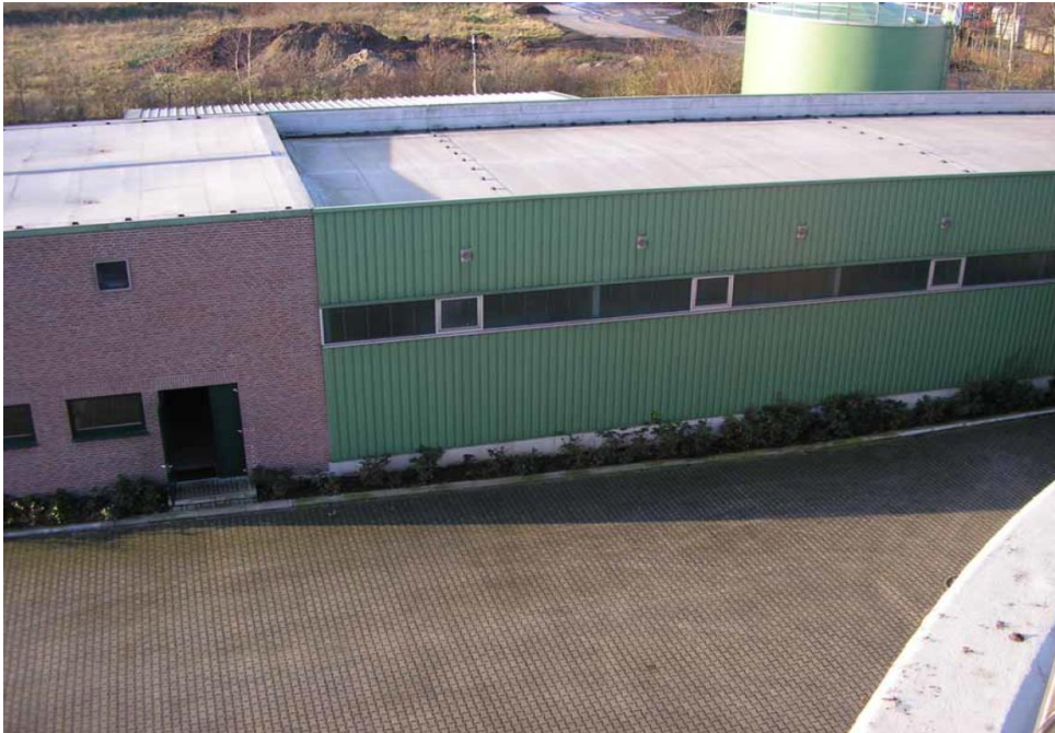
Abbildung 2: Filterhalle der Flockungsfiltration KA Harsewinkel
