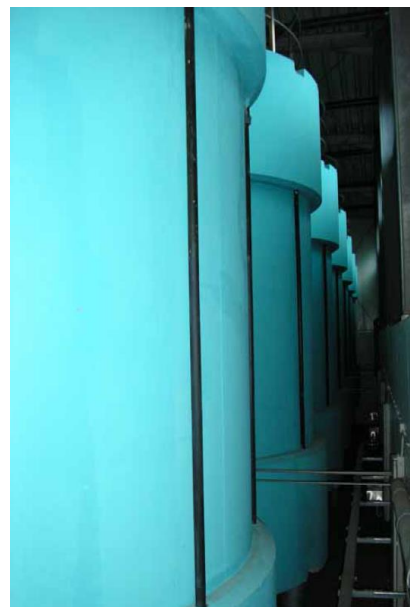
Abbildung 3: Blick auf eine der beiden Filterstraßen (je 7 Einzelfilter) der Flockungsfiltration
