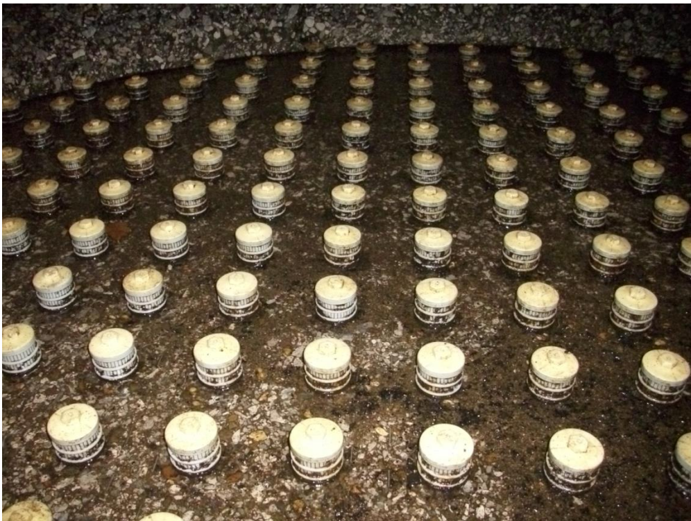
Abbildung 7: Blick auf den Düsenboden und die Luftpolsterdüsen mit zylindrischem Kopf und Schlitzweite 0,50 mm in Filter Nr. 9
