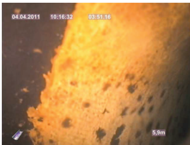
Abbildung 4-43: Fleckenbildung in einem Liner (hier bei Objekt 5AXI-V-V-XI (24))
