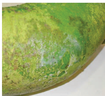
Abbildung 4-71: Probestück I, Schlauchliner, zusammenhängender Lufteinschluss
