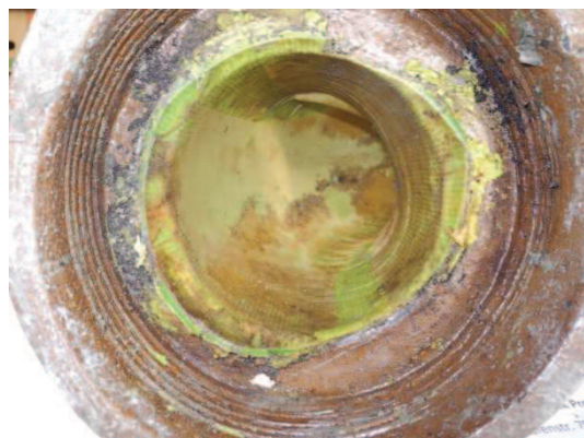
Abbildung 4-59: Probestück I, Schlauchliner in Altrohr, Bogenstück 90°
