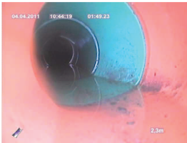
Abbildung 4-42: In offener Bauweise sanierter Leitungsabschnitt mit einem Unterbogen (hier bei Objekt 5AXI-V-V-XI (24))
