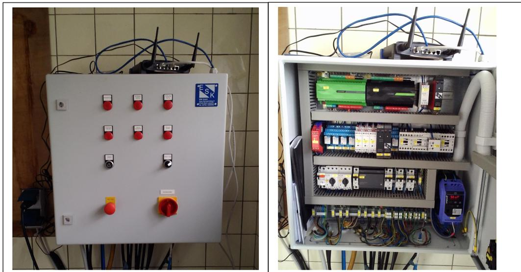
Abbildung 18 Schaltkasten der SPS
