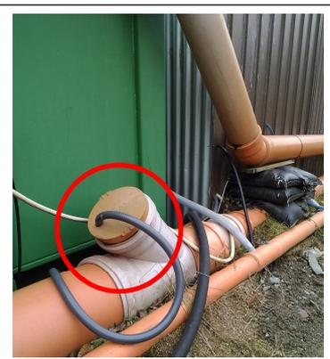
Abbildung 22 Probenahmestelle Ablauf
