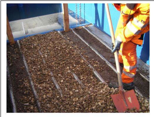
Abbildung 8 Aufbau Mineralfilter Bauzustand 1
