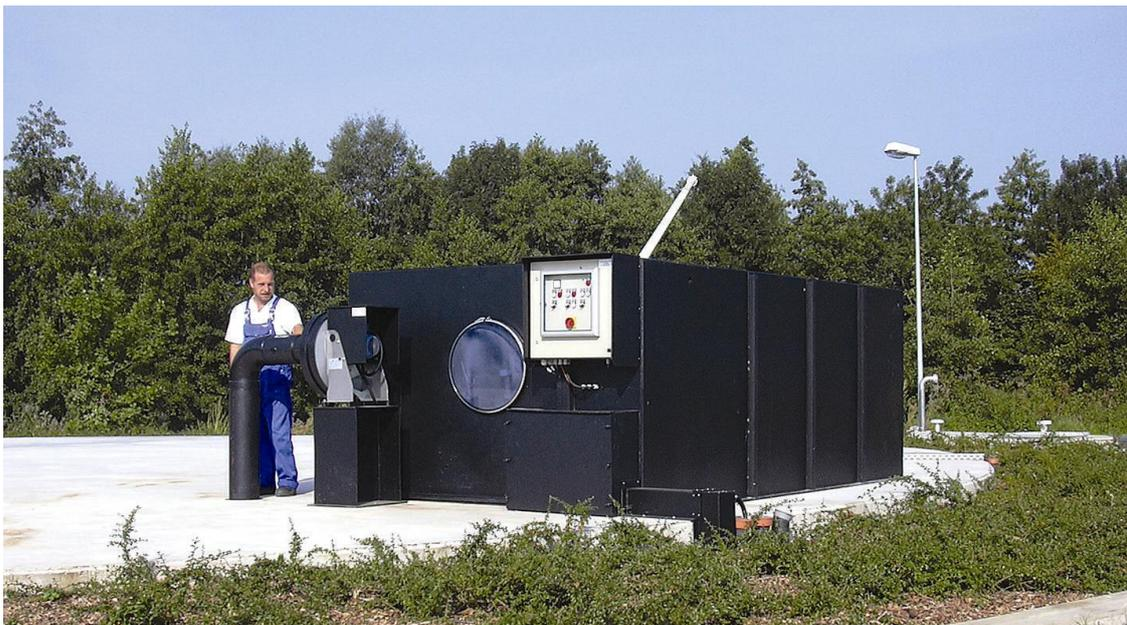
Abbildung 3-14: Biofilter auf der Stahlbetondecke des Pufferbehälter 1
