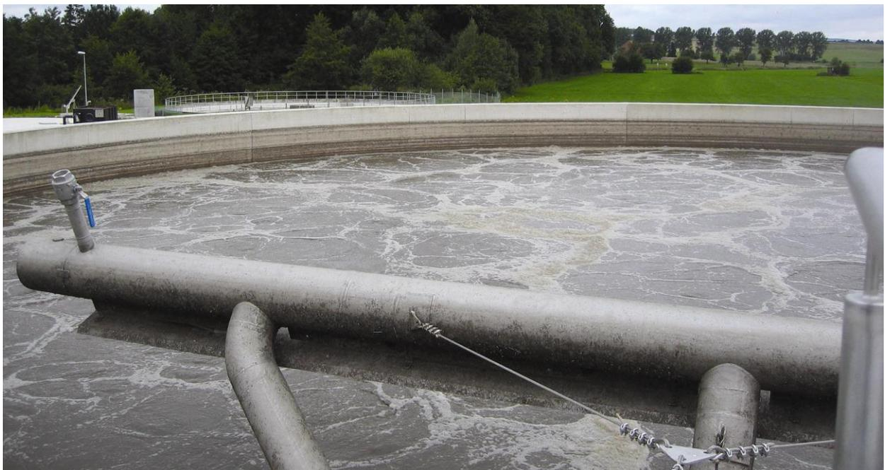
Abbildung 3-8: SBR 3 mit Blick auf den Dekanter und dem belüfteten Belebtschlamm sowie Puffer 1 und Puffer 2 im Hintergrund
