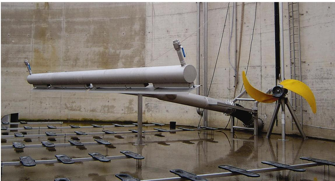
Abbildung 3-9: Dekanter, Belüfterplatten und Rührer im SBR 1
