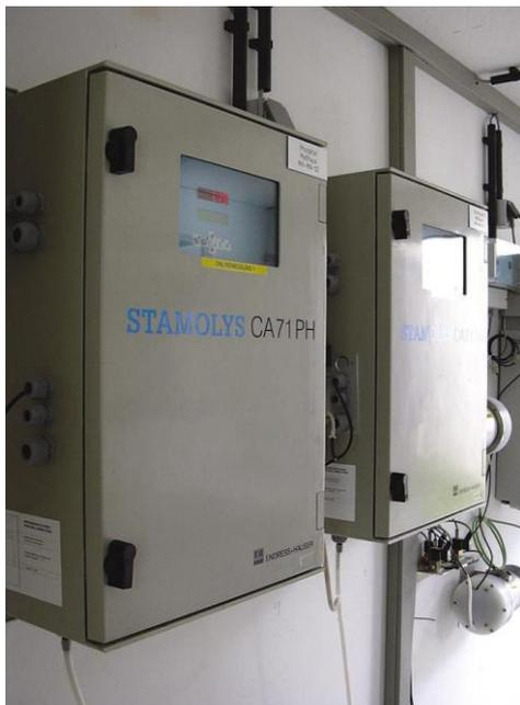
Abbildung 3-10:  $\text{NH}_4\text{-N}$ -,  $\text{NO}_3\text{-N}$ - und  $\text{PO}_4\text{-P}$ -Online-Messgeräte im Meßhaus
