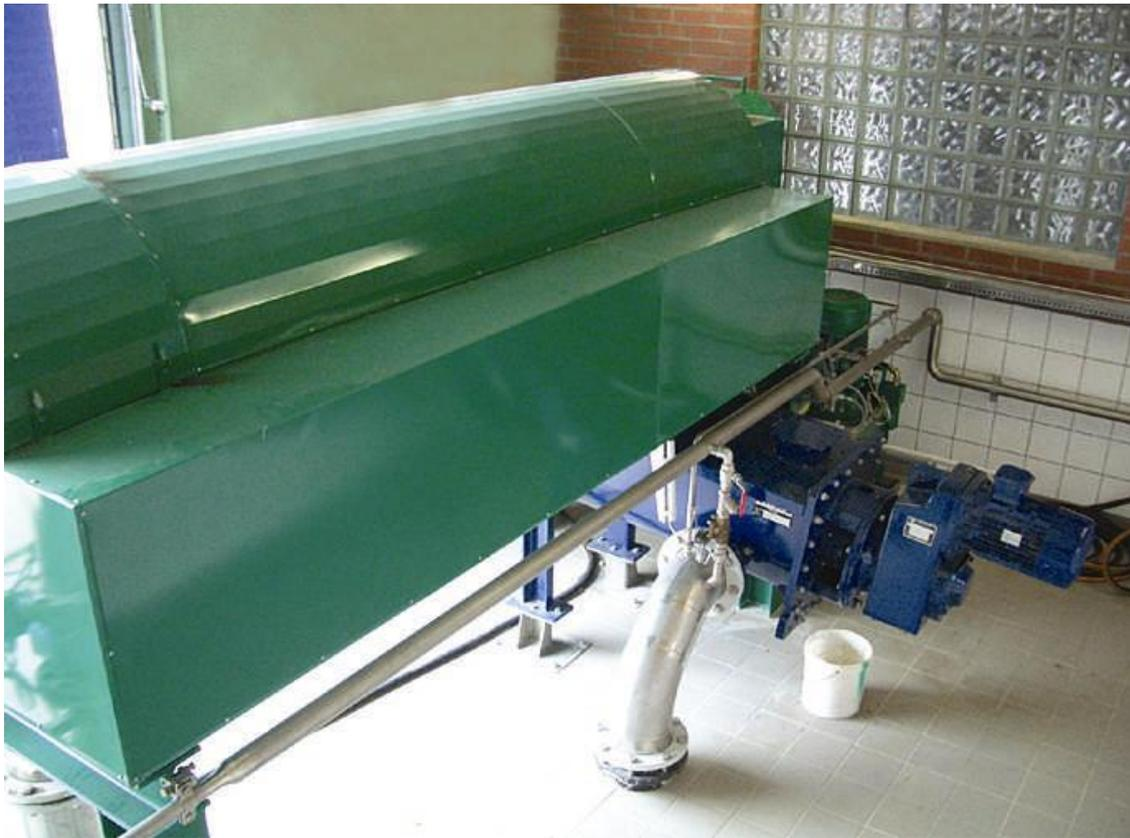
Abbildung 3-12: Zentrifuge zur Schlammentwässerung
