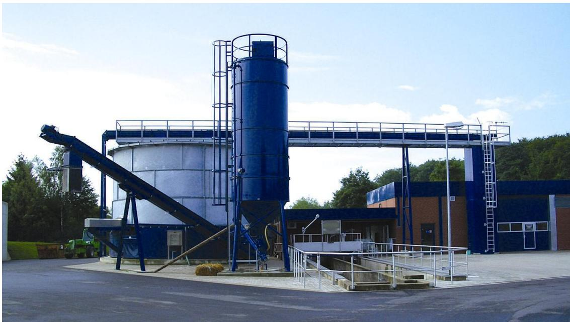
Abbildung 3-13: Kalksilo, Speichersilo, Schlammförderung
