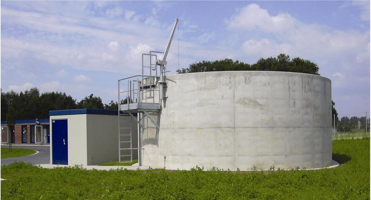
Abbildung 3-11: Überschussschlamm-Vorlagebehälter
