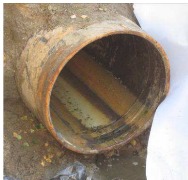
Bild 107 Neu installierter Liner (links,) Druckliner mit Quick-Lock Linerendmanschette nach einigen Jahren Betriebsdauer (mitte), Lineraufbau (rechts) [109]
