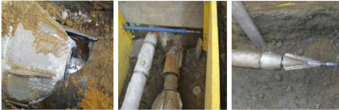
Bild 118 Geborstenes Rohr (links), Einschub des Berstgestänges (mitte) sowie Berstlafette (rechts) [120]
