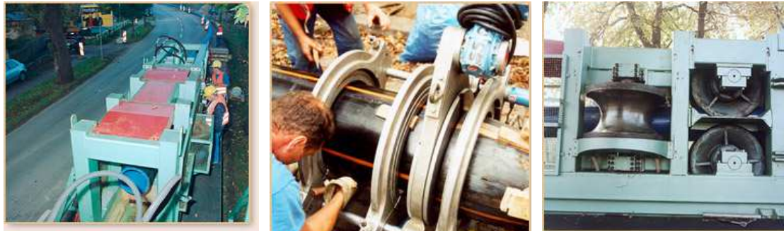
Bild 109 Mechanische Reduzierung des Rohrstrangdurchmessers durch Halbkugelwalzenpaare (links und rechts) sowie der Einzug in das bestehende Altrohr durch eine Pressvorrichtung (mitte) [110]
