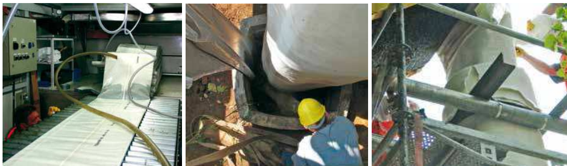
Bild 104 Rollenbahn (links), Einführung des Schlauchliners in ein Eiprofil (mitte), über einen Inversionsturm wird der Inliner in die Haltung eingebracht (rechts) [104]
