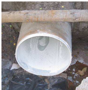
Bild 107 Neu installierter Liner (links,) Druckliner mit Quick-Lock Linerendmanschette nach einigen Jahren Betriebsdauer (mitte), Lineraufbau (rechts) [109]
