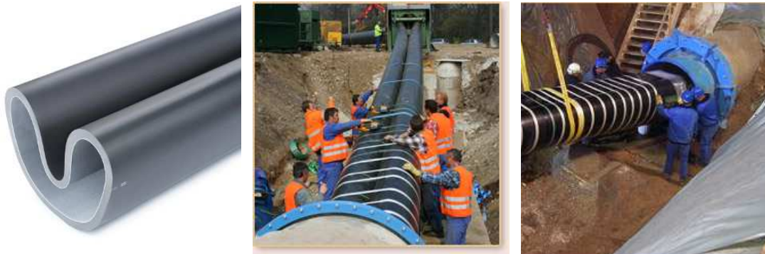
Bild 111 Verformter U-Liner (links) sowie das Verlegeverfahren (rechts) [112]
