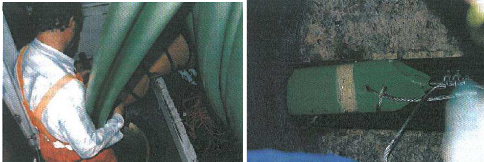
Bild 112 Einzug des Omega Liners [114]
