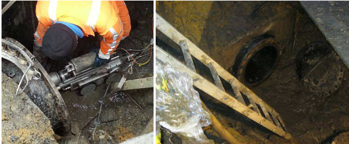
Bild 6 Einführung des Kanalradars in die zu prüfende Strecke (links), Öffnung der Haltung (rechts)
