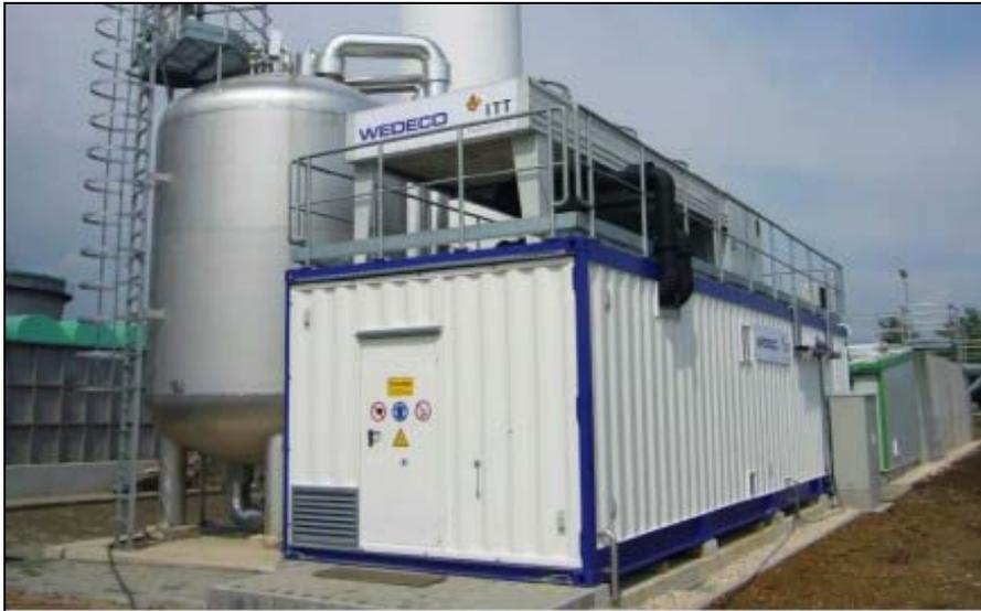
Bild 48: Beispiel Aufstellung Ozongenerator in Container (Quelle: Fa. Xylem)
