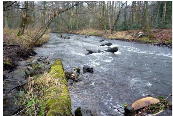
künstlich erhöht: raue Gleite mit Wurzelstubben
