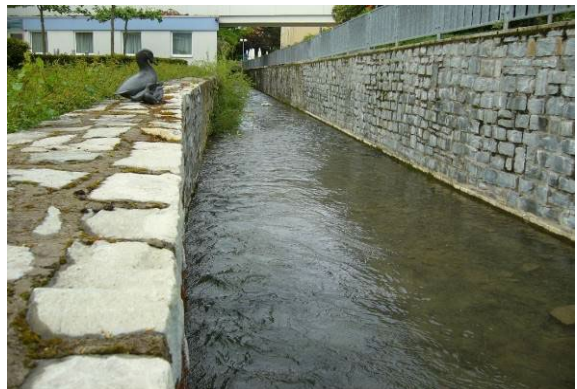
technisches Regelprofil (Kastenprofil)
