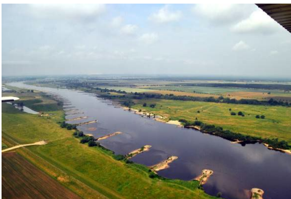
massiver Verbau: Buhnen
