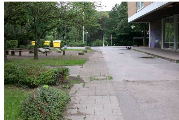
Lauf verengt (auf Foto nicht sichtbar)
