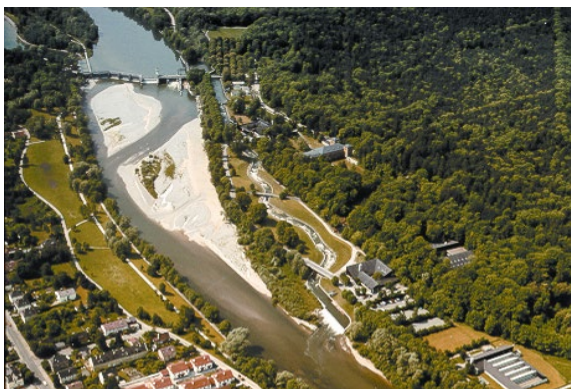
bewegliches Wehr > 1 m mit Umgehungsgerinne (rechts)
