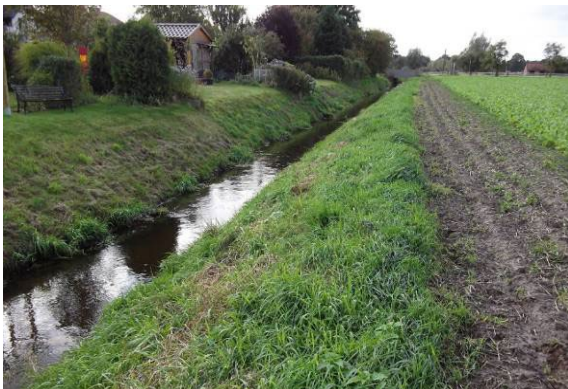
technisches Regelprofil (Trapezprofil)
