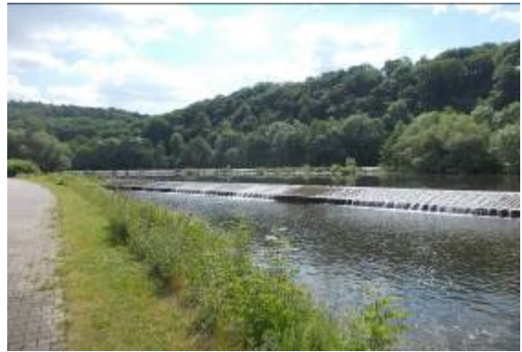
glatte Rampe (Streichwehr)
