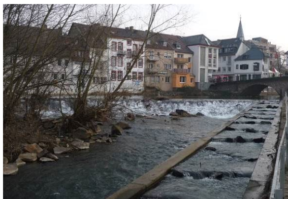
Absturz > 1 m mit Fischwanderhilfe (Fischtreppe)
