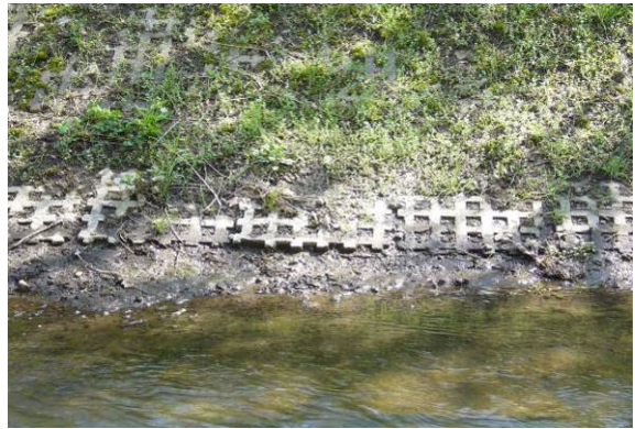
massiver Verbau: Gittersteine
