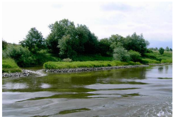
massiver Verbau: Leitwerk
