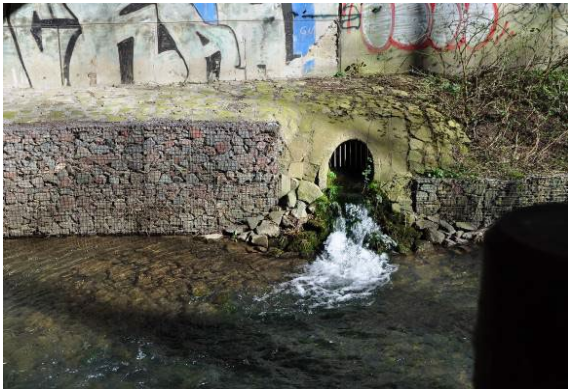
massiver Verbau: Steinsatz, unverfugt (Gabionen)
