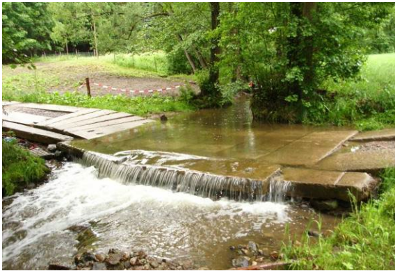
Massivsohle ohne Sediment, \leq 10 m (Furt)
