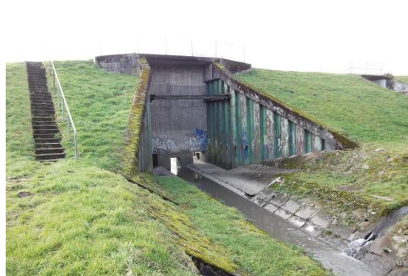
> 20 m, ohne Sediment (Durchfluss durch den Erdkörper eines HRB)
