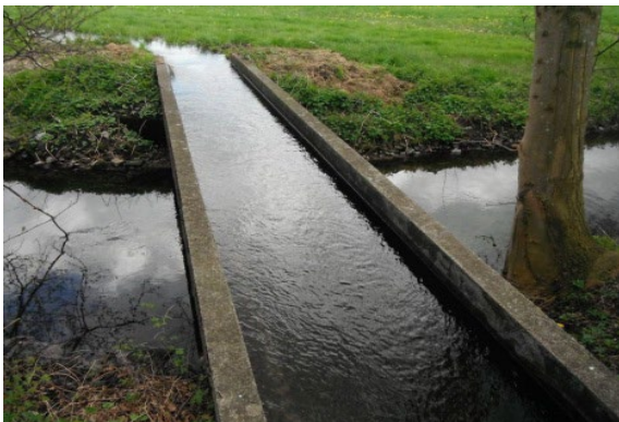
KEIN Düker (Kreuzungsbauwerk)
