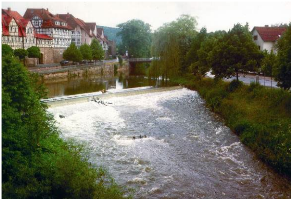
Absturz, unterhalb raue Rampe
