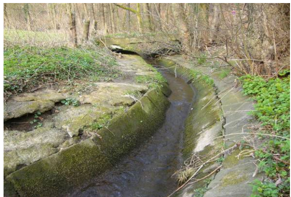
massiver Verbau: Beton
