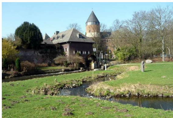
bewegliches Wehr > 1 m mit Umgehungsgerinne
