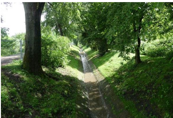
Massivsohle ohne Sediment
