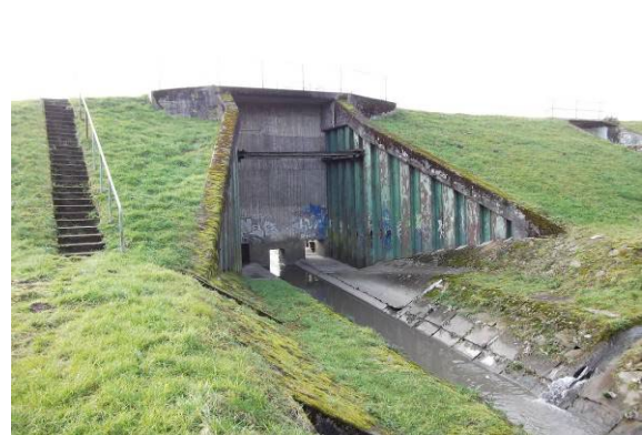
Lauf verengt (Durchfluss durch den Erdkörper eines HRB)
