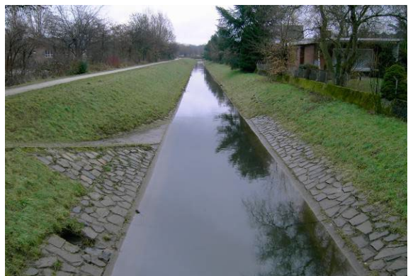
Massivsohle ohne Sediment
