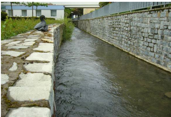
massiver Verbau: Mauerwerk (verfugt)
