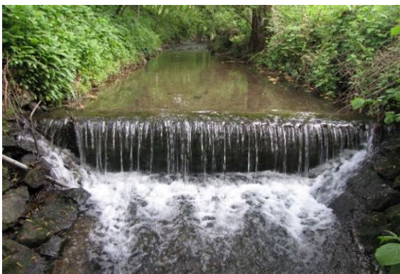
mittlerer Absturz 0,3 – 1 m
