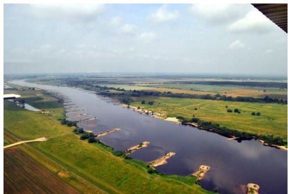
Profil mit Buhnenausbau
