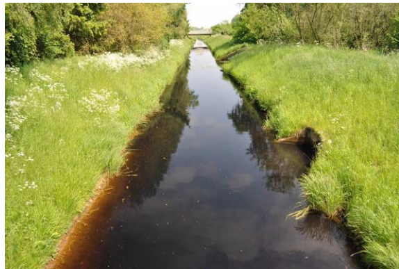
Sohle nicht erkennbar
