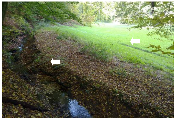
Gewässer an Talrand verlegt
