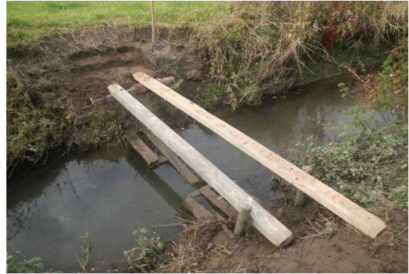
KEIN Kreuzungsbauwerk (wildes Bauwerk)
