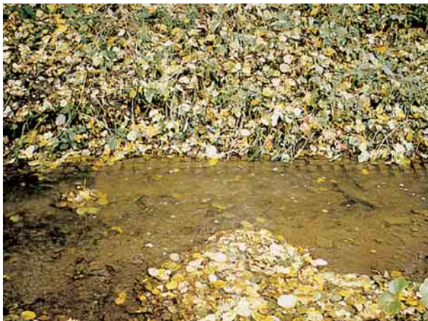
Massivsohle mit Sediment
