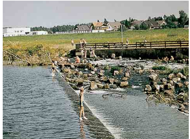
Absturz mit Teilrampe
