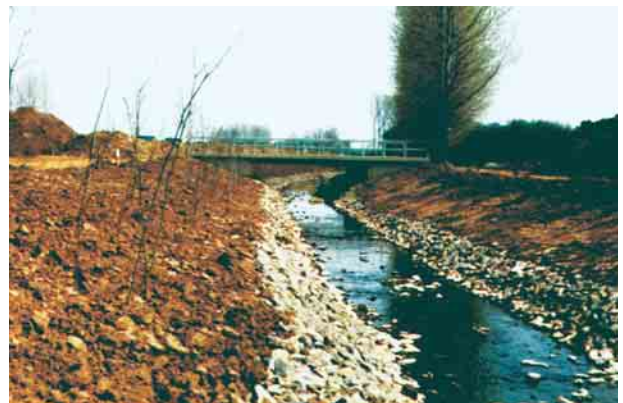
Abb. 6: Ausbau des X-Baches unterhalb A-Dorf
