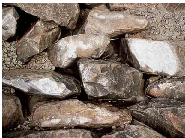
Sohlenverbau (Steinstückung)
