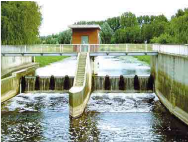
Absturz mit technischem Fischpass (links)
