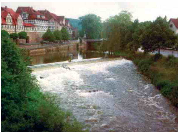
Absturz, unterhalb raue Rampe
