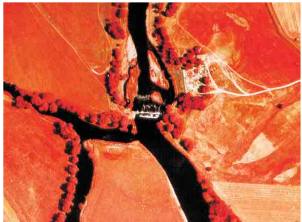
Absturz mit Umgehungsgerinne
