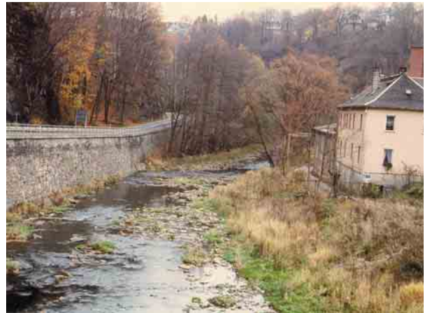
links Mauer, rechts kein Uferverbau
