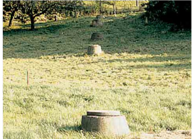
Landschaft, verrohrter Gewässerabschnitt
