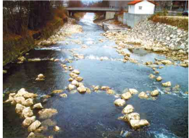
raue Rampe (Gumpenbauweise) (Neigung 1:3 bis 1:10)
