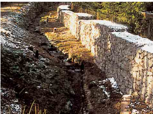
eingeschränkte Auenüberflutung (Gabionen als Schutzbauwerk)
