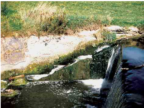
Absturz mit Fischtreppe
