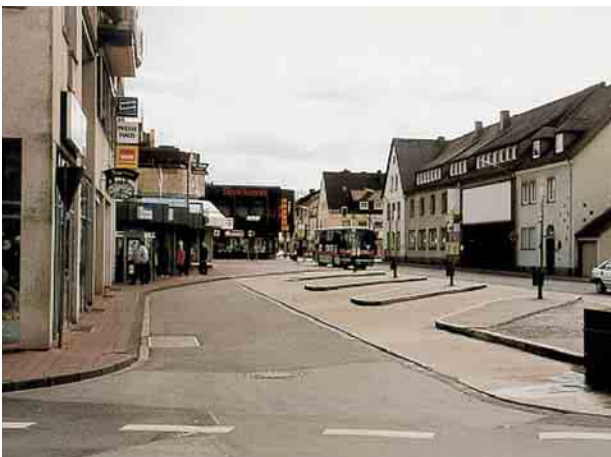
Ortslage, verrohrter Gewässerabschnitt
