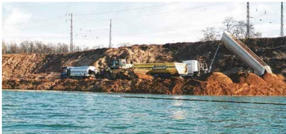
Abb. 3: Baggersee Gremberg Süd: Die Böschung wurde wegen des Baus der ICE-Trasse verstärkt (2001). Foto: LANUV/FB 55
