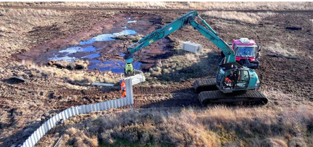
Abb. 7: Einbau einer Spundwand zur Wiedervernässung eines Moores. Foto: Martin Hochbruck (Stoker Media)
