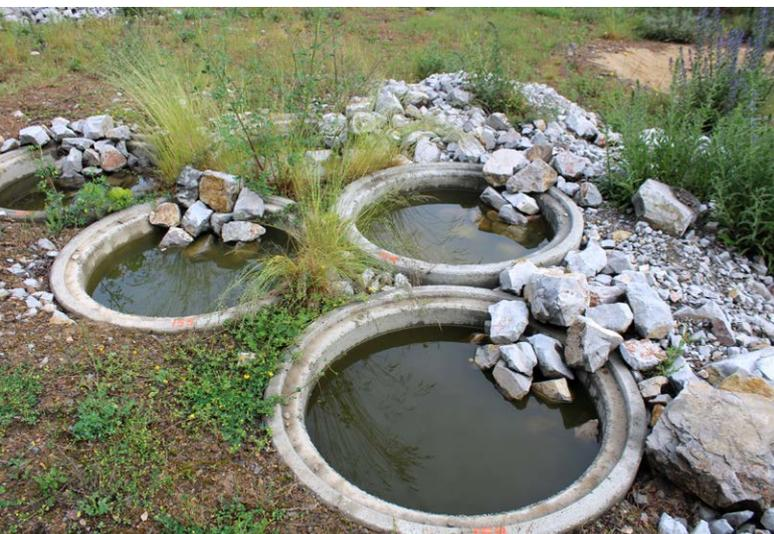
Abb. 4: Kleingewässer aus Brunnenringen (Fertigteil) verfügen über einen nachträglich eingebauten Ablass. Foto: Wil Niessen
