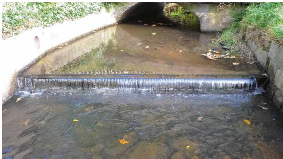
Abb. 3: Krebssperrre in einem Bereich mit Uferverbau. Zum Schutz vor seitlichem Überklettern sollen auf die Ufermauern im Sperrbereich noch Bleche aufgesetzt werden.
