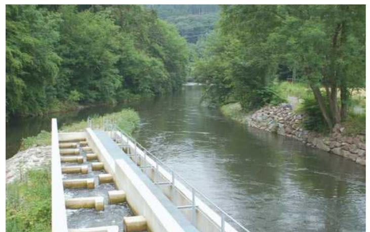
Abb. 4: Schlitzpass an der Wasserkraftanlage Auerkotten
