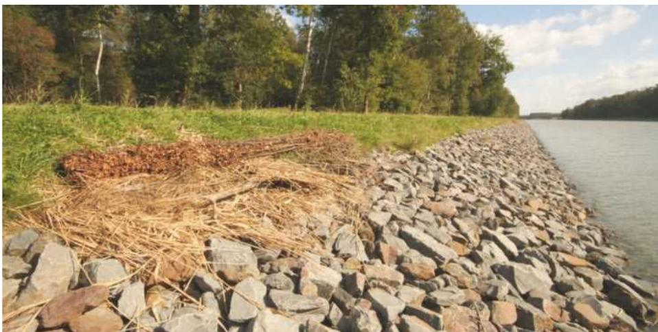
Abb. 5: Neue Uferböschung mit Blocksteinschüttung. Im Übergang zur grasbestandenen Böschung wurden Reisigbündel und Schilfhalmteppiche als Strukturanreicherungsmaßnahmen eingebracht. Foto: A. Geiger
