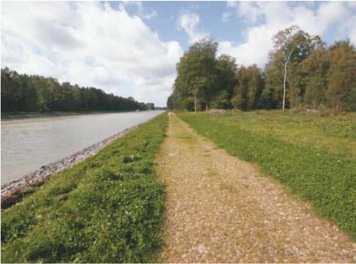
Abb 2: Gesamtansicht der wiederhergestellten Kanalufer mit Blocksteinschüttung, grasbestandener oberer Böschung und Betriebsweg mit einer 20 Zentimeter dicken Packlage aus Schotter-Splitt. Daran schließen sich die neu geschaffenen Ersatzlebensräume mit den Blockriegelschüttungen (Bildmitte) und Totholzhäufen an.
