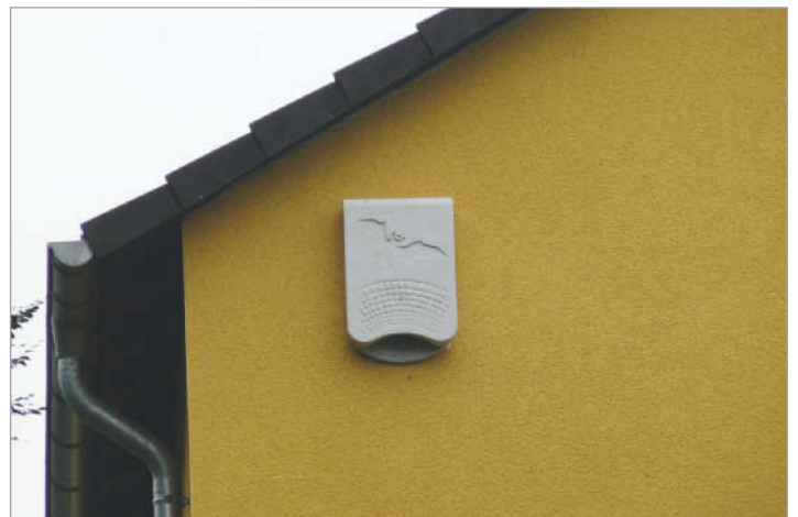
Detailaufnahme dieses nachträglich an die Fassade angebrachten Fledermauskastens.
