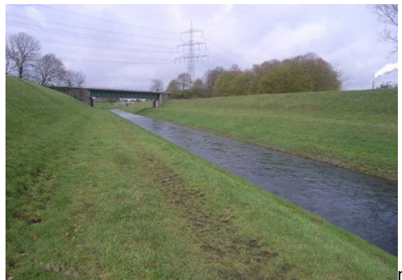
Bioingennered bank protection
