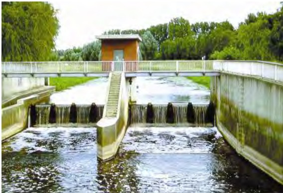
bewegliches Wehr > 1 m mit Fischwanderhilfe (links)
