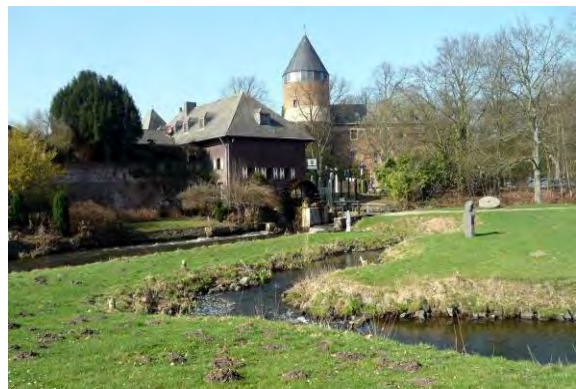
bewegliches Wehr > 1 m mit Umgehungsgerinne
