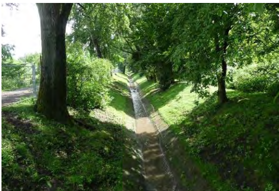
Massivsohle ohne Sediment
