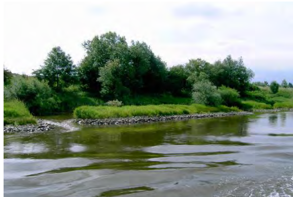
massiver Verbau: Leitwerk
