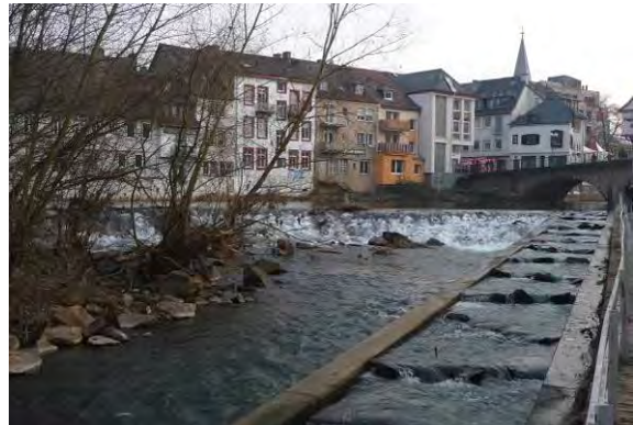
Absturz > 1 m mit Fischwanderhilfe (Fischterrasse)
