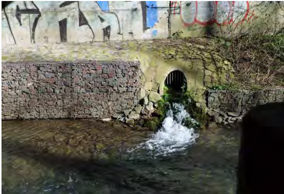
massiver Verbau: Steinsatz, unverfugt (Gabionen)
