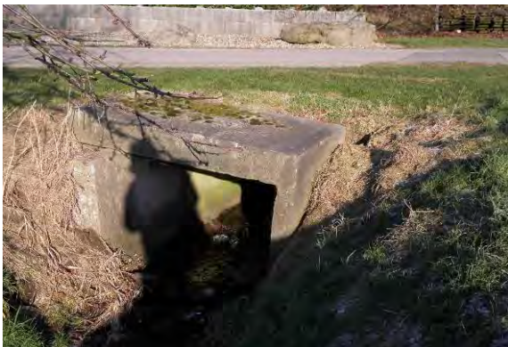
Verrohrung/Überbauung > 20 m, mit Sediment
