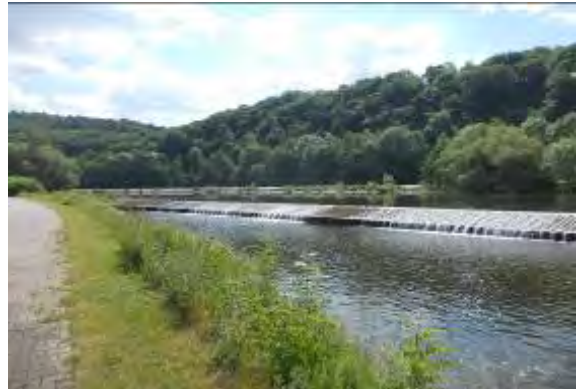
glatte Rampe (Streichwehr)
