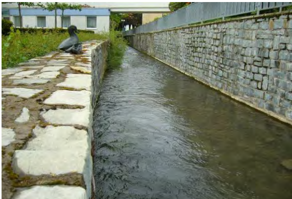
massiver Verbau: Mauerwerk (verfugt)
