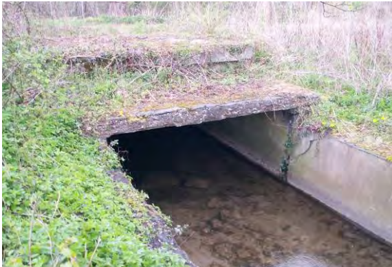
Verrohrung/Überbauung > 10 m, mit Sediment
