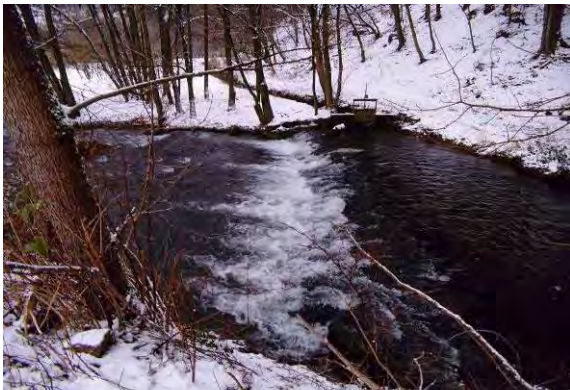
Ausleitungsstrecke (links) > 50 – 100 m
