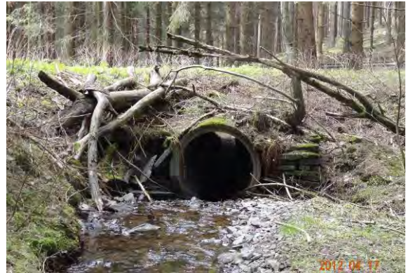
Durchlass, Lauf verengt, ohne Sediment
