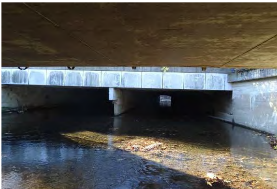
Verrohrung/Überbauung > 100 m, mit Sediment
