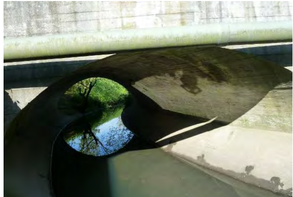
Verrohrung/Überbauung > 10 m, ohne Sediment
