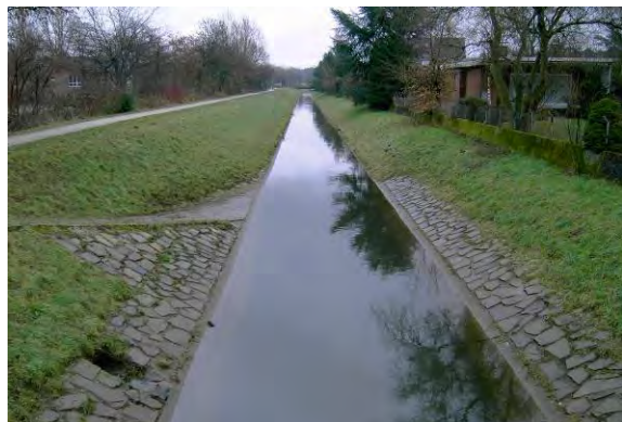
Massivsohle ohne Sediment
