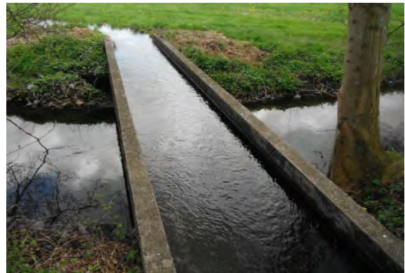
(Wasser)Brücke, strukturell nicht schädlich
