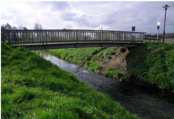
Brücke, strukturell nicht schädlich
