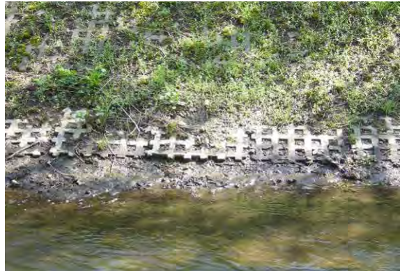
massiver Verbau: Gittersteine
