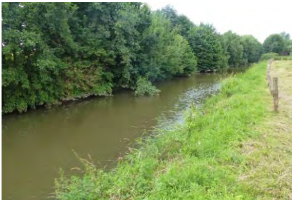
nicht erkennbar (staureguliert)
