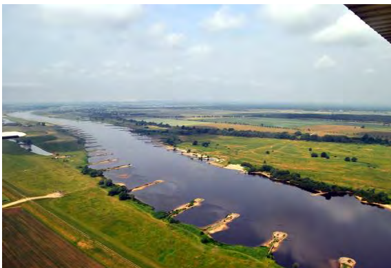
massiver Verbau: Buhnen
