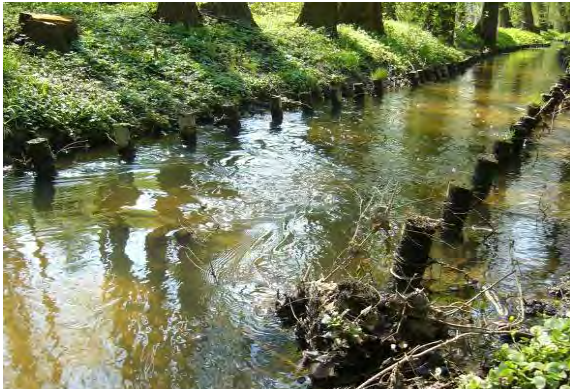
technisches Regelprofil, verfallend
