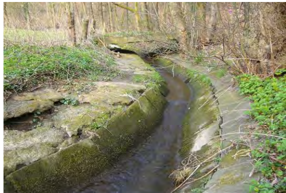
massiver Verbau: Beton
