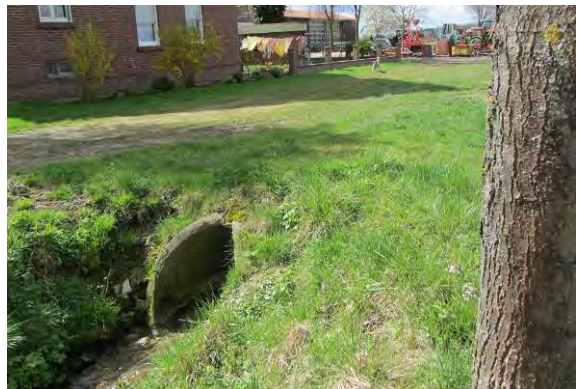
Verrohrung/Überbauung > 20 m, ohne Sediment
