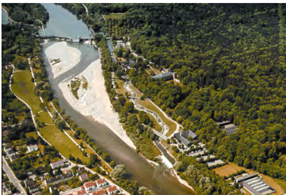
bewegliches Wehr > 1 m mit Umgehungsgerinne (rechts)
