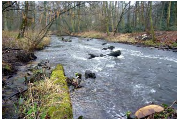
künstlich erhöht: raue Gleite mit Wurzelstubben
