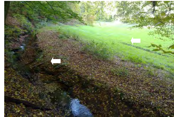
Gewässer an Talrand verlegt
