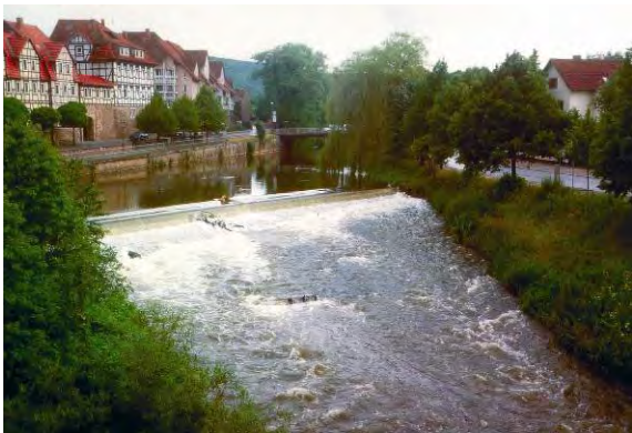
Absturz, unterhalb raue Rampe
