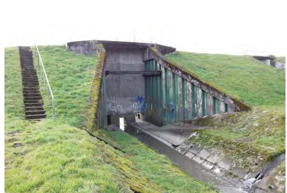
Durchlass, Lauf verengt, ohne Sediment (Durchfluss durch den Erdkörper eines HRB)
