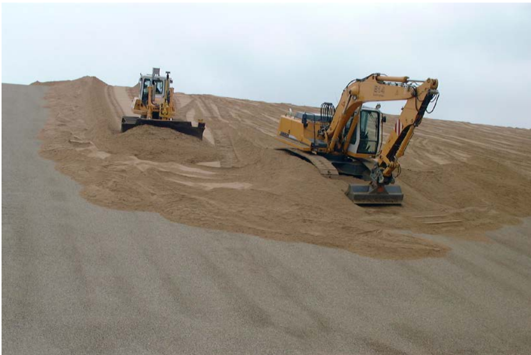
Abbildung 14 Einbau einer Kapillarsperre Aufbringen der Kapillarschicht auf den Kapillarblock
