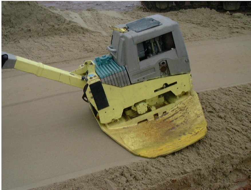
Abbildung 10 Verdichtung einer TRISOPLAST-Dichtungsschicht
