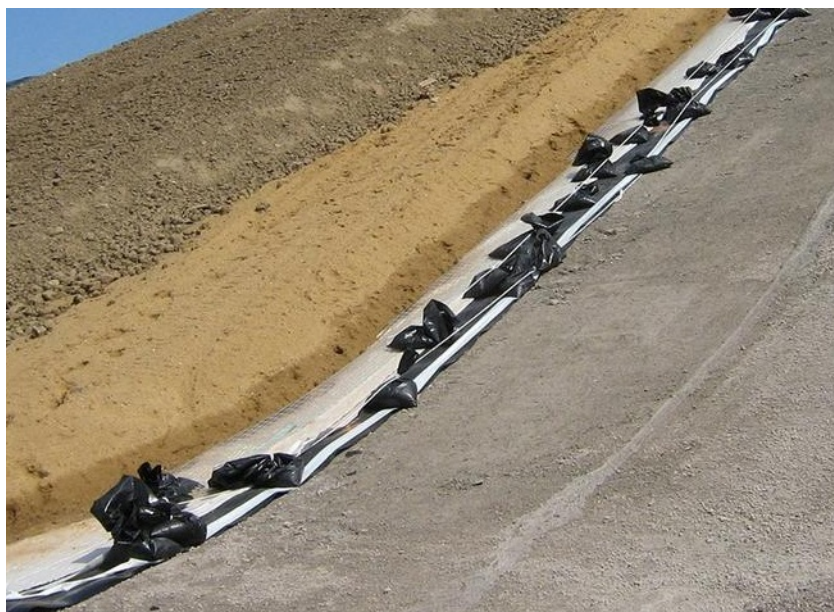
Abbildung 7 Rekultivierungsschicht mit Zoneneinteilung Gestuffer Aufbau der Rekultivierungsschicht auf Geogitter, Dränmatte und Kunststoffdichtungsbahn Foto: HYDR.O. Geologen und Ingenieure
