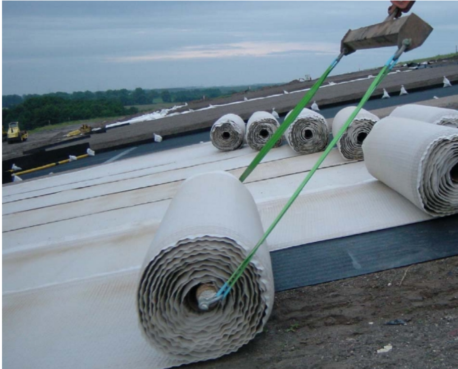
Abbildung 9 Verlegung einer Kapilllarblockbahn (KBB) Foto: G quadrat Geokunststoffgesellschaft mbH
