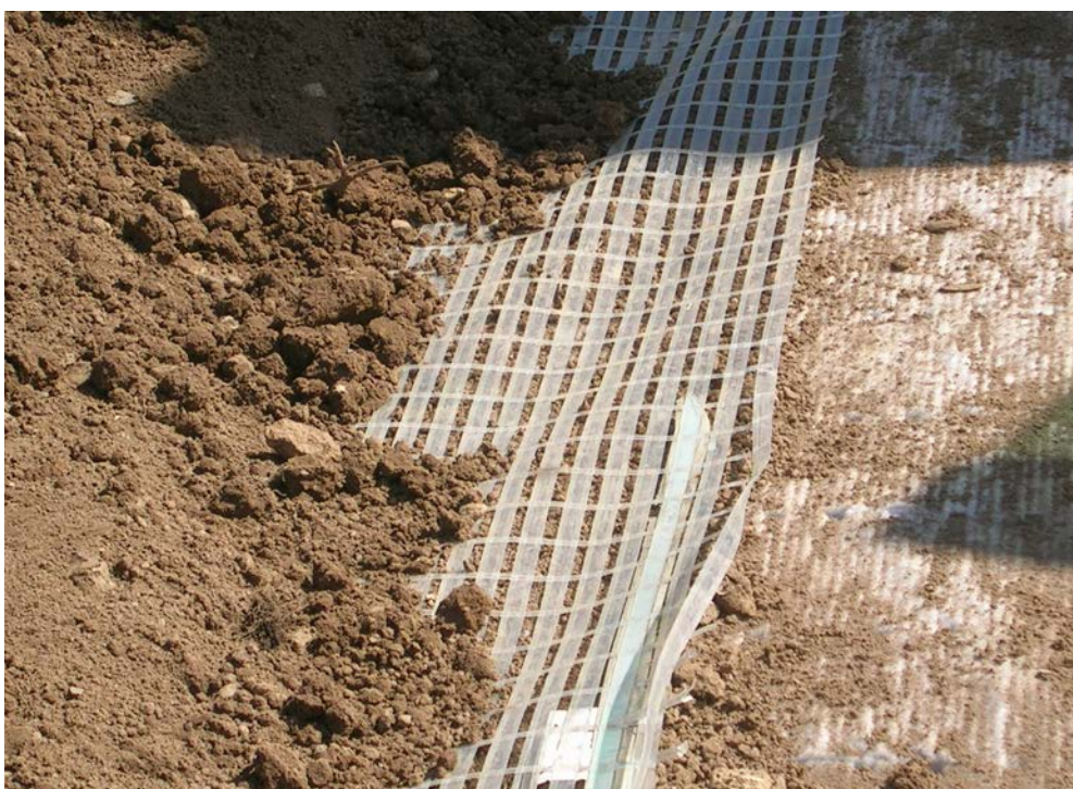
Abbildung 5 gelegtes Geogitter in einer steilen Böschung
