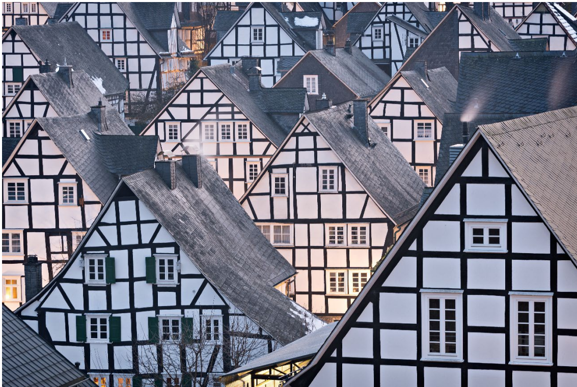
Abbildung 16: Die Emissionen im Sektor Haushalte und Kleinverbrauch werden zum großen Teil vom Raumwärme- und Warmwasserbedarf geprägt. Im Jahr 2024 liegen die Emissionen dieses Sektors bei 21,9 Mio. t CO 2 -eq (Quelle: AdobeStock/iPics).
