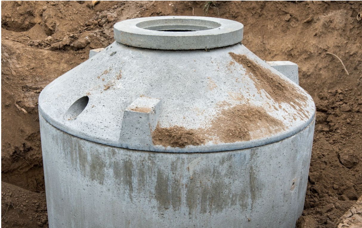
Bild 6.1: Bau einer Kleinkläranlage (Foto: Mario Hösel)
