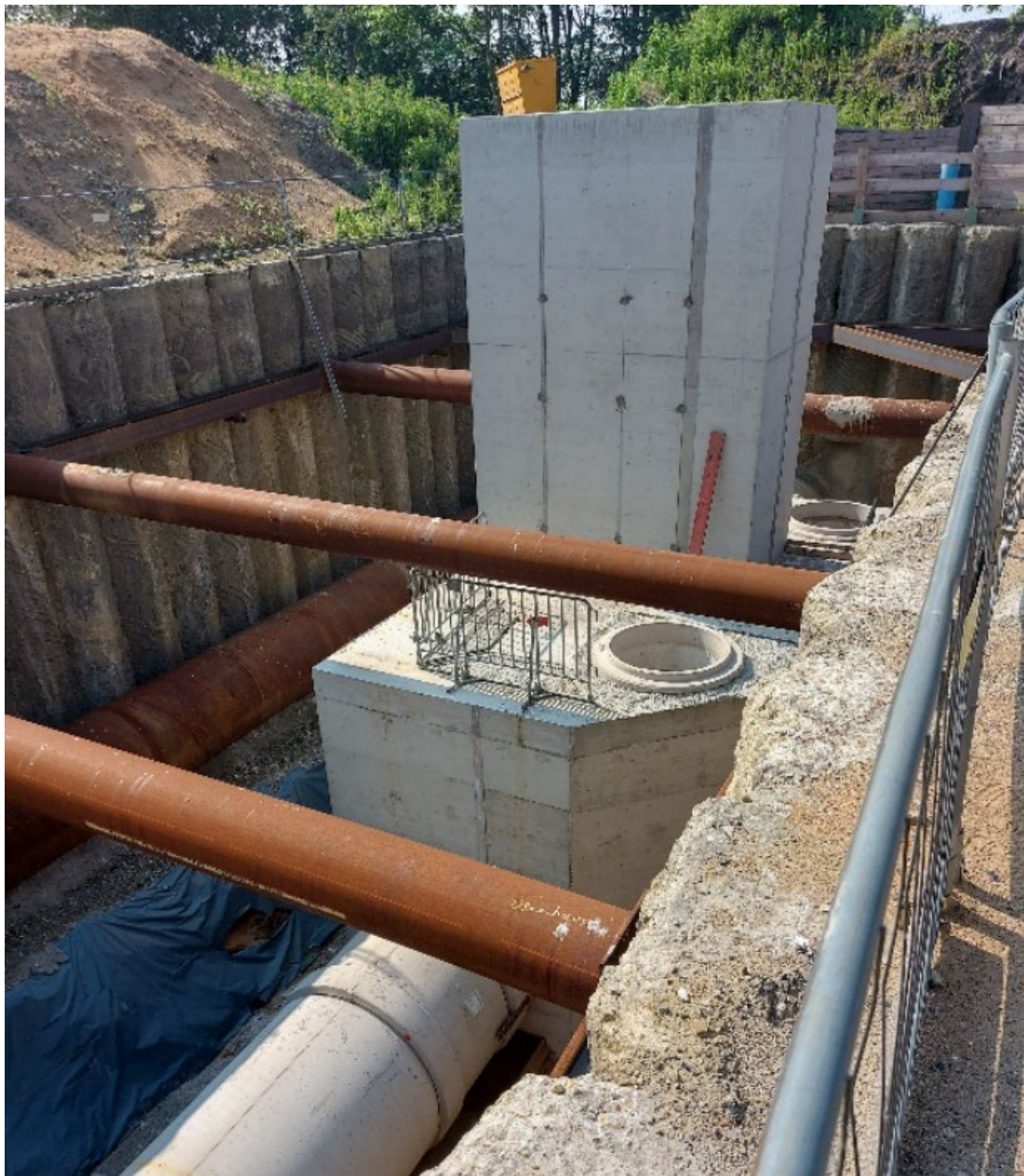
Bild 4.2: Regenüberlaufbecken im Bau (Foto: Jörg Strauch)
