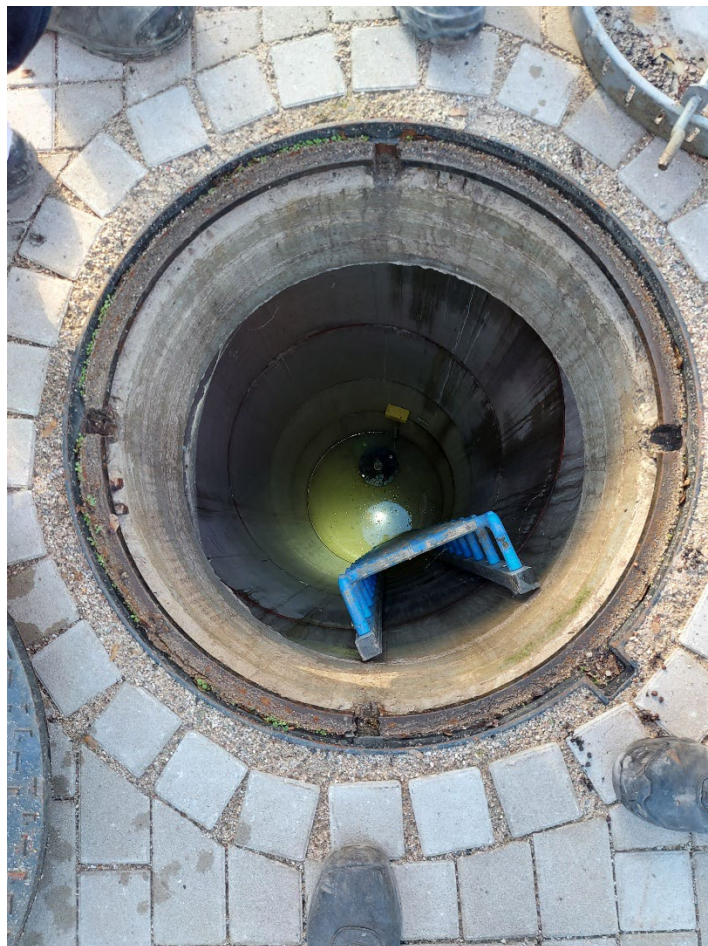
Bild 2.1: Einstiegsschacht zum Kanalsystem (Foto: Jörg Strauch)
