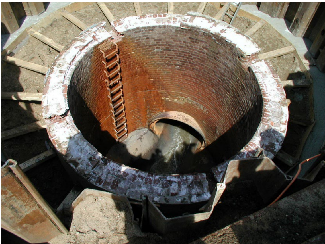
Bild 3.2: Anbindung an Bestandsschacht (Foto: Lars Bittger)
