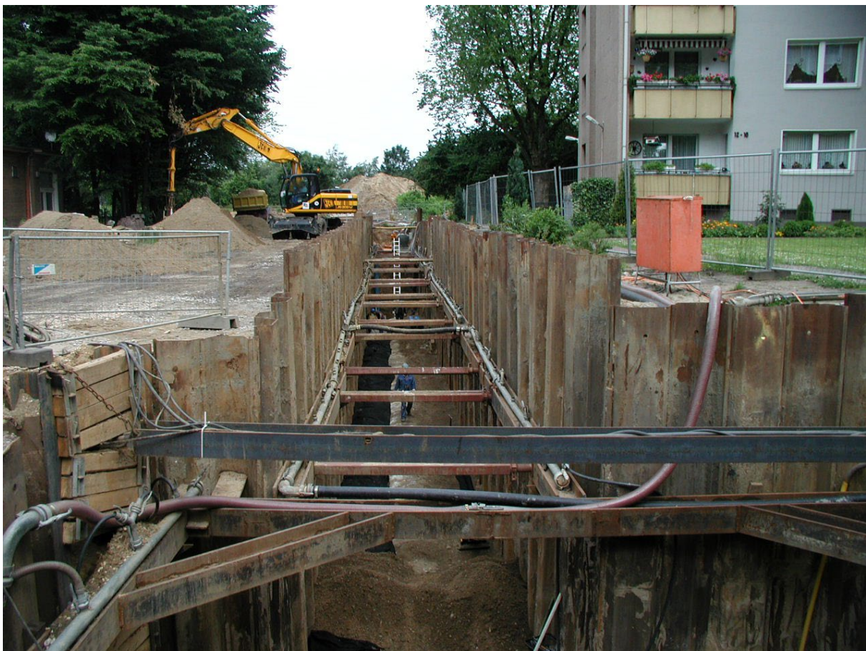
Bild 3.1: Kanalverlegung in offener Bauweise (Foto: Lars Bittger)
