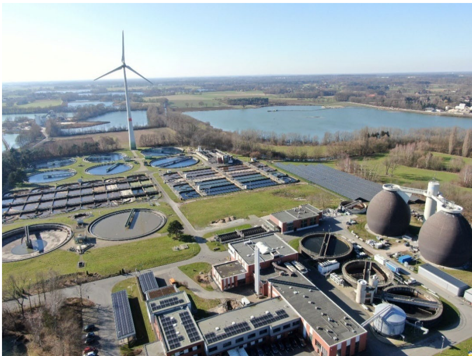
Bild 5.1: Luftbild der Kläranlage Paderborn (Foto: STEB Paderborn)
