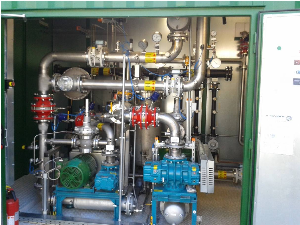
Abbildung 8: Anlagen zur Behandlung von Deponiegas sind Beispiele für den Sektor 4A Abfalldeponien. Das verwertbare Gutgas wird einem BHKW zugeleitet. Das Schlechtgas (Methan) wird flammlos verbrannt. Darüber hinaus ausgetretenes Gas wird im THG-Emissionsinventar erfasst. Im Jahr 2014 sind im Sektor 4A 0,2 Mio. t CO 2eq emittiert worden. (Quelle: LANUV / Michael Trapp)
