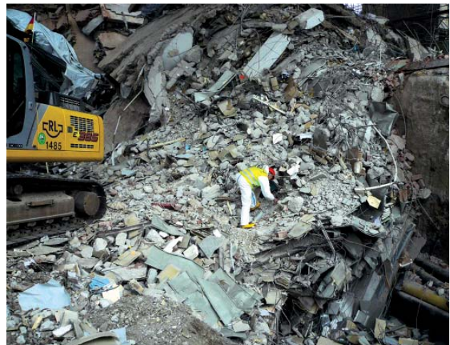
Probennahme nach dem Einsturz des Stadtarchivs Köln 2009
