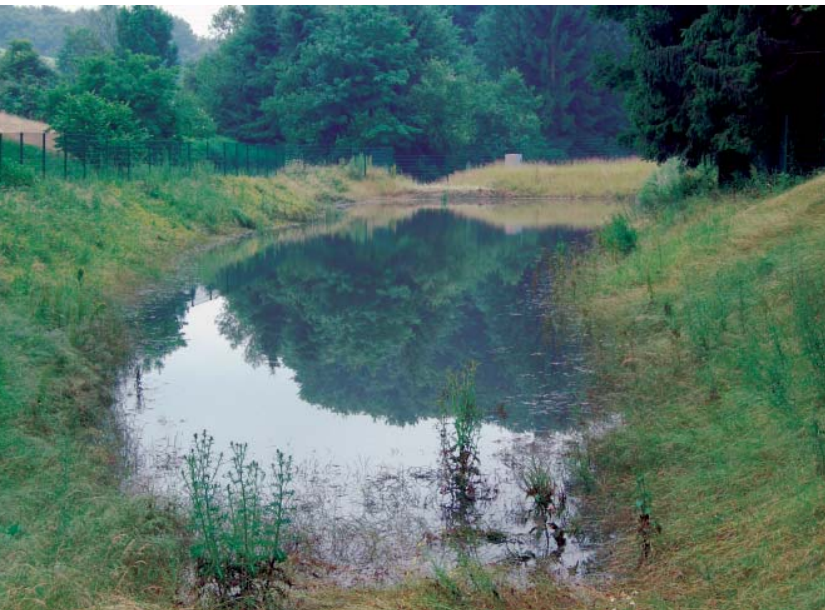
Regenrückhaltebecken
