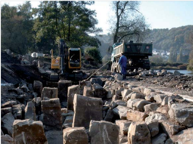
Bau einer Fischaufstiegshilfe
