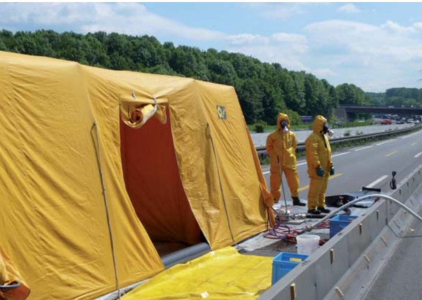
Dekontaminationsplatz der Feuerwehr
