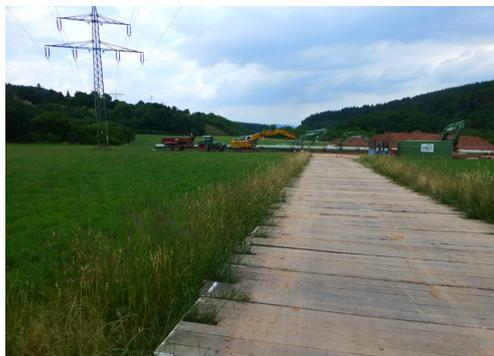
Auswahl geeigneter Befestigungssysteme: Stahl-Hohlkammerplatten für hohe mechanische Belastungen (oben links); mineralische Baustraße auf Geovlies für hohe mechanische Belastungen (oben rechts); Kunststoff-Verlegeplatten für geringe mechanische Belastungen (unten links); Holzbohlen / Baggermatratzen für hohe mechanische Belastungen (unten rechts)
