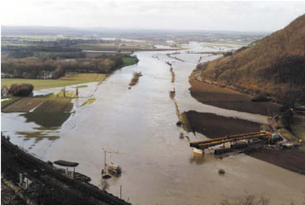
Abb. 9: Die Weser beim Durchbruch durch das Wiehen-/Wesergebirge bei Porta Westfalica kurz oberhalb der Weser-Messstation Porta. Die Bauarbeiten an der neuen Weserbrücke mußten während des Hochwassers im Januar 1994 unterbrochen werden. Der Wasserstand am Pegel Porta lag bei 6,04 m.
