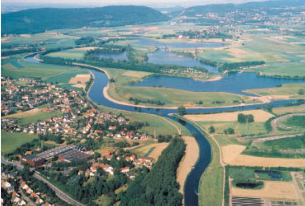
Abb. 5: Einmündung der Werre (am unteren Bildrand) in die Weser bei Bad Oeynhausen. Die rechte Weseraue wird nach erfolgter Auskiesung als Freizeitzentrum genutzt. Im Hintergrund das Wiehen- und Wesergebirge mit der Porta Westfalica.
