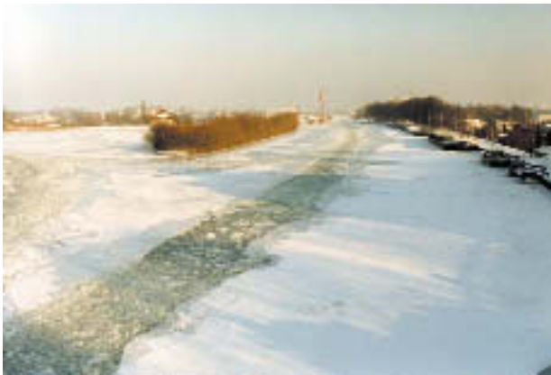
Abb. 4: Mittellandkanal vor der Überquerung der Weser in Minden, Blick nach Osten auf das Wasserstraßenkreuz
