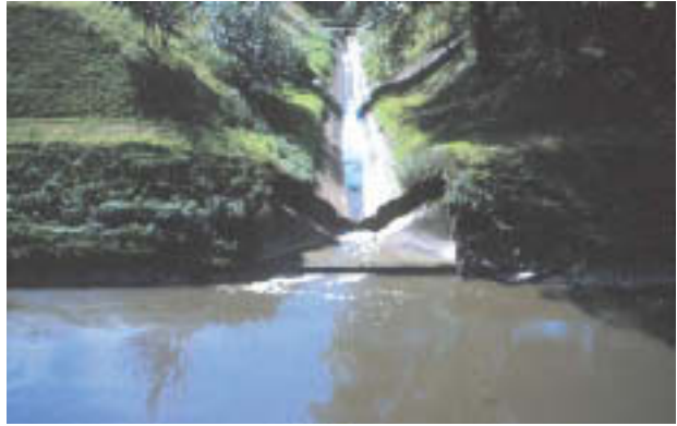
Abb. 18: Ein Beispiel für die wasserbauliche Gestaltung der Emschernebegewässer (Einmündung des Sellmannsbaches in die Emscher).
