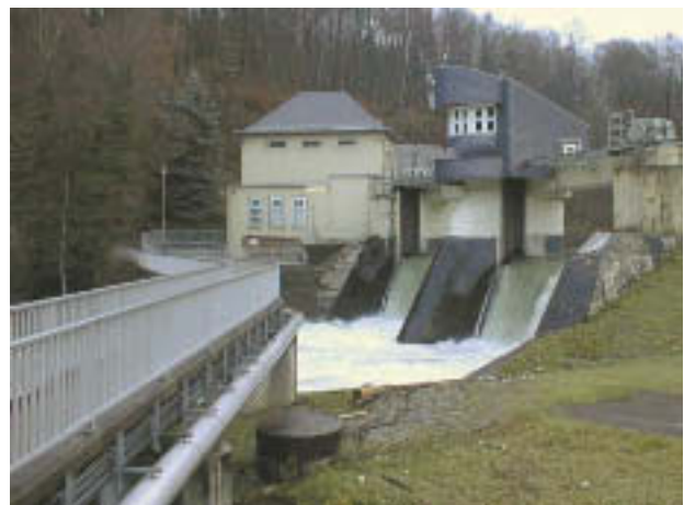
Abb. 3: Das Aggerstauwehr Wiehlmünden
