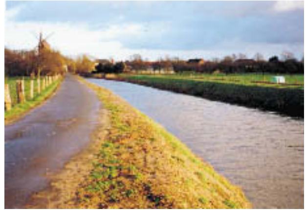
Abb. 2: Issel technisch ausgebaut bei Werth 1999
