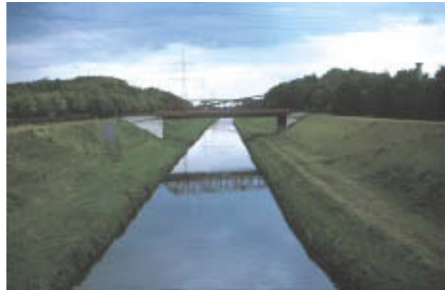
Abb. 1: Kanalisiert und mit Abwasser gefüllt. Die Emscher unterhalb des Schwarzbaches bei Gelsenkirchen-Horst.
