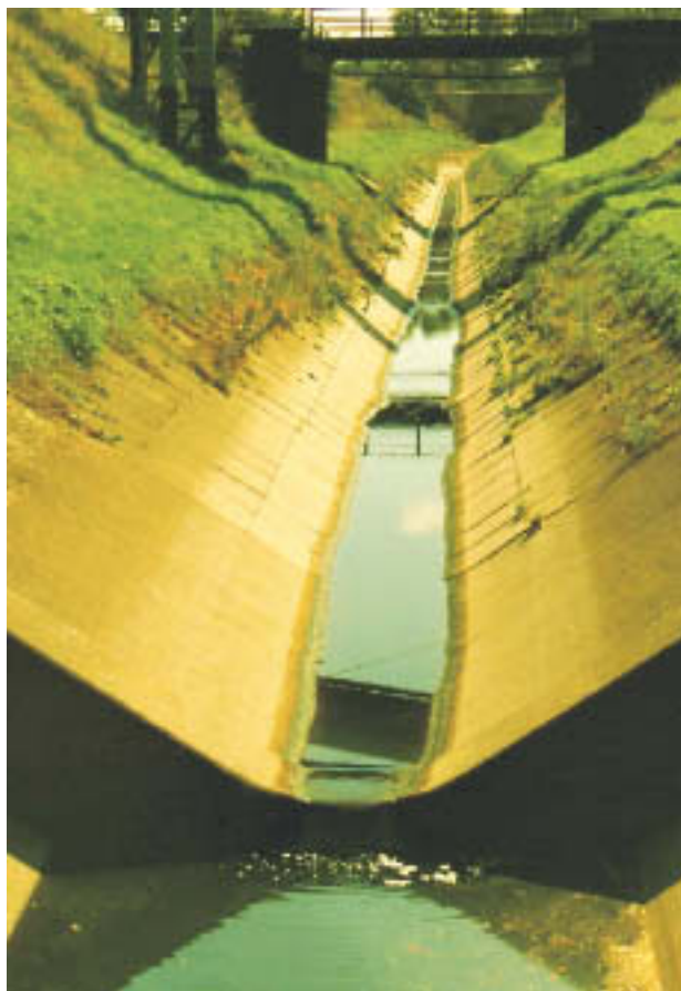
Abb. 1: Typisches Emschernebegewässer, nach rein hydraulischen Gesichtspunkten technisch zur Schmutzwasserableitung umgebaut.
