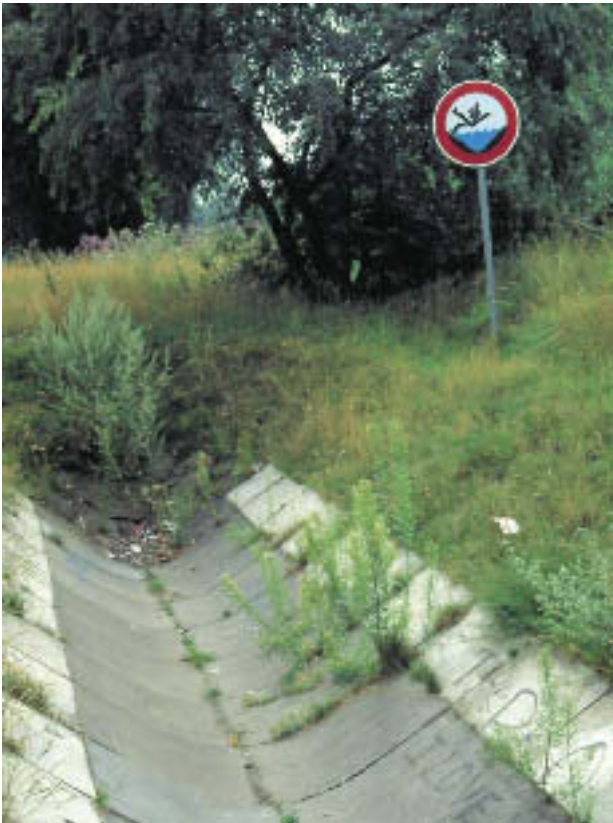
Abb. 12: Läppkes Mühlenbach: Morphologischer Zustand vor 1988. Für die Nachwelt erhaltener Abschnitt der ehemaligen Schmutzwasserrinne.
