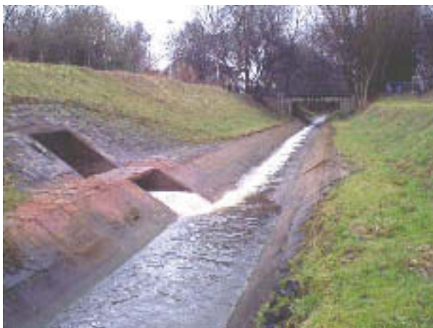
Abb. 8: Grubenwassereinleitung der Zeche „AUGUSTE VICTORIA“ in den zum hydraulischen Gerinne umgestalteten Sickingmühlenbach, einem linksseitigen Nebengewässer der Lippe.
