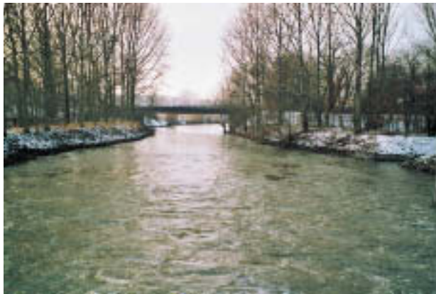
Abb. 3: Lippe unterhalb des Wehres Uentrop
