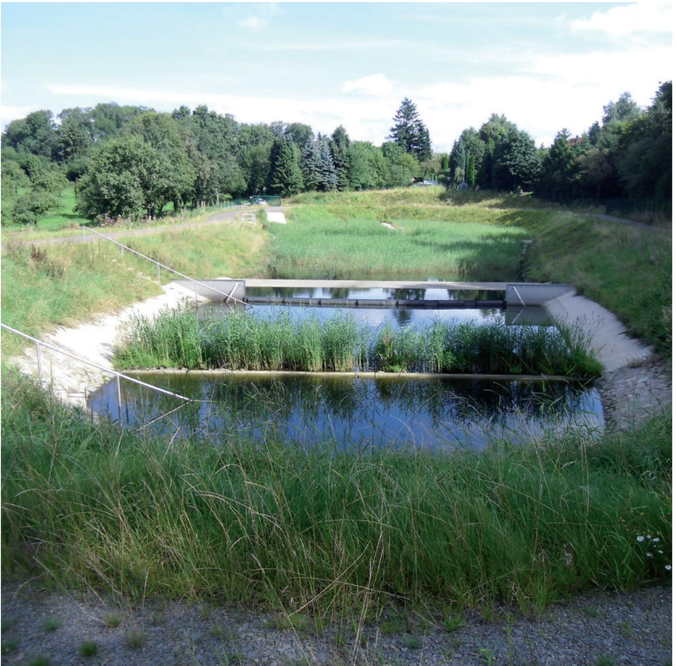
Retentionsbodenfilter zur Niederschlagsentwässerung von Verkehrsflächen
