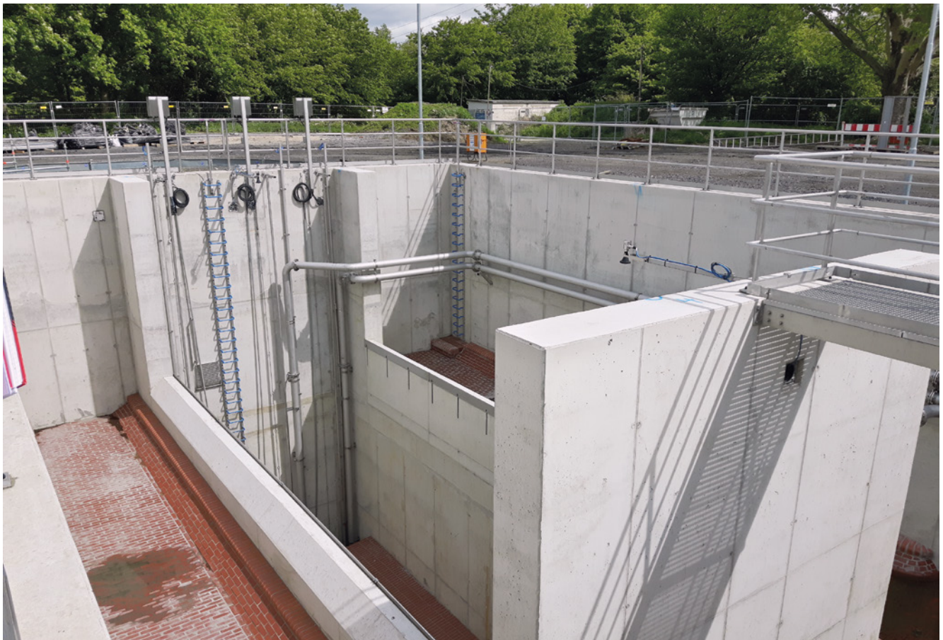
Entlastungsschwelle des Stauraumkanals Essen-Klaumerbruch
