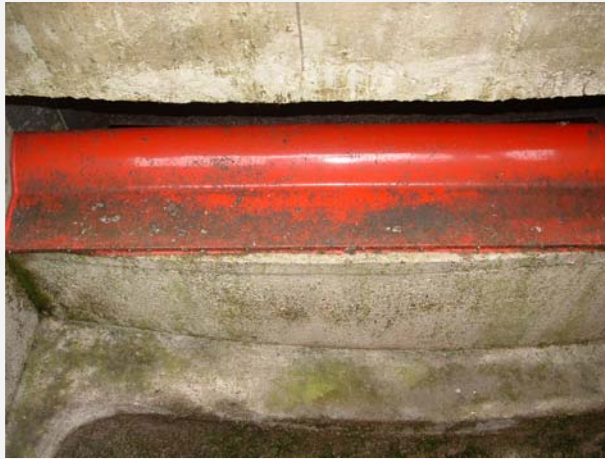
Abb. 1 (fortgesetzt): Beispiele für scharfkantige und profilierte Entlastungsschwellen
