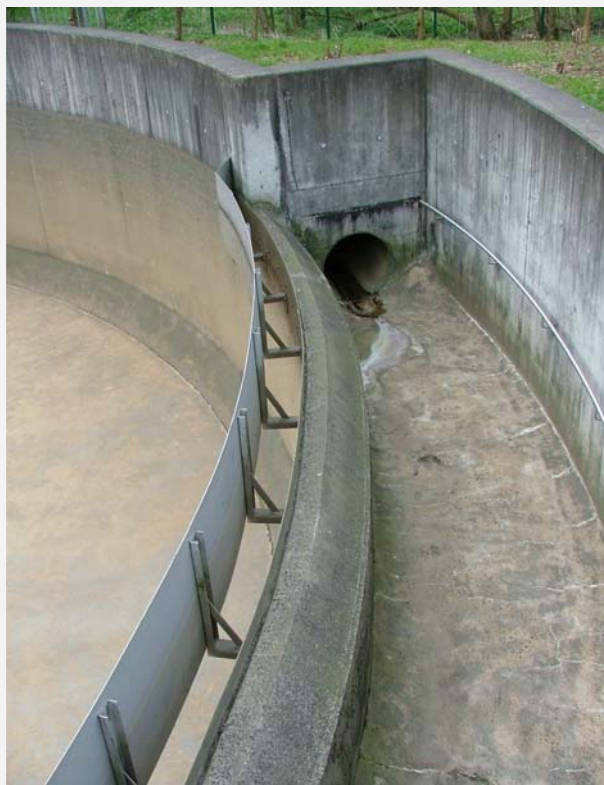
Abb. 1: Beispiele für scharfkantige und profilierte Entlastungsschwellen
