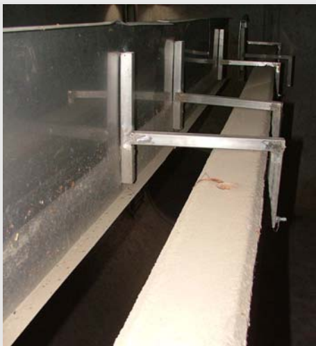
Beckenüberlaufschwelle mit Tauchwand
