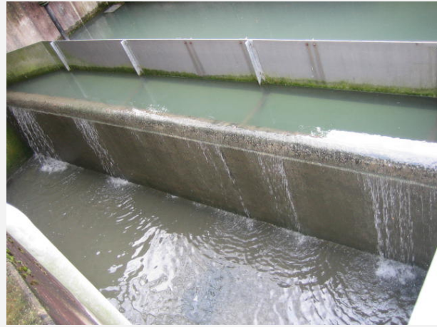
Abb. 1 (fortgesetzt): Beispiele für scharfkantige und profilierte Entlastungsschwellen
