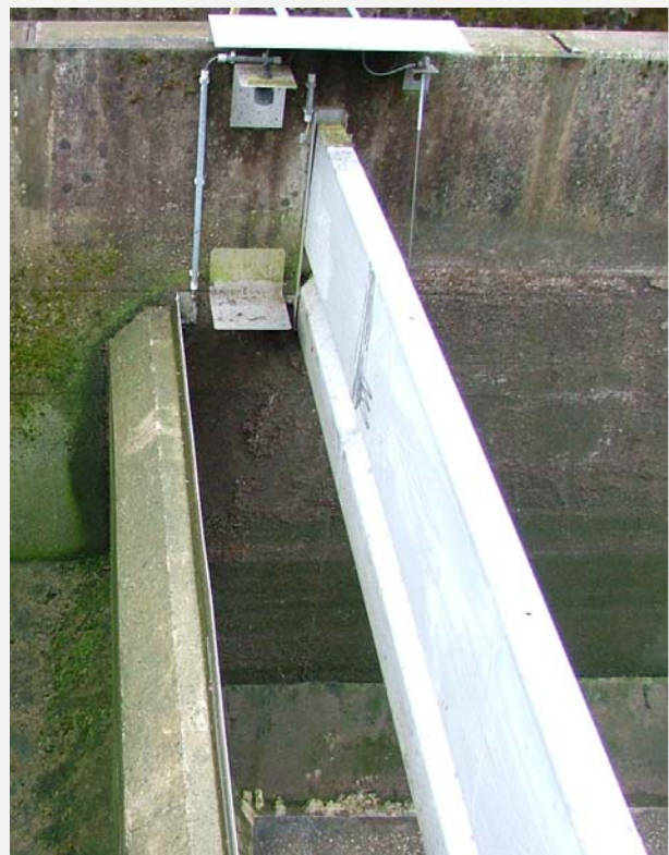
Abb. 1: Beispiele für scharfkantige und profilierte Entlastungsschwellen
