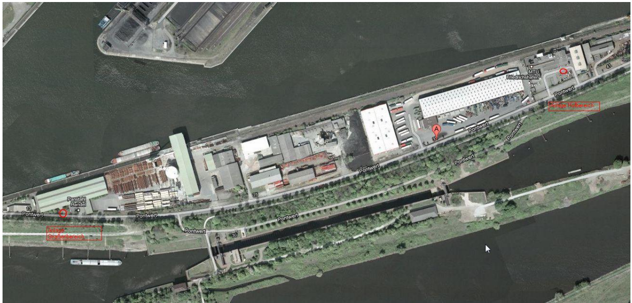
Abbildung 1: Übersicht der überwachten Anlagen
