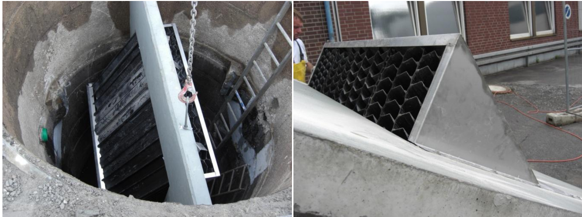
Abbildung 5: Mittelwand mit Kunststofflamellen
