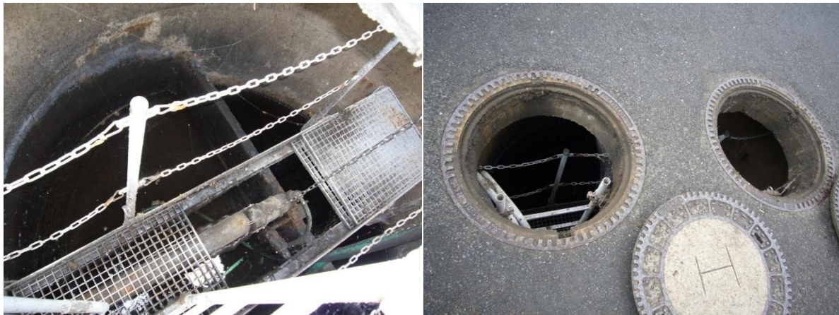
Abbildung 3: Altanlage vor dem Umbau
