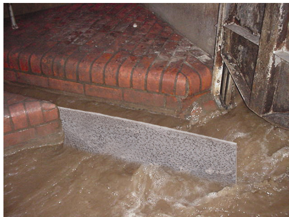
Bild 5.3: Hauptschott des Stauraumkanals und Zulaufgerinne zum Wasserrad
