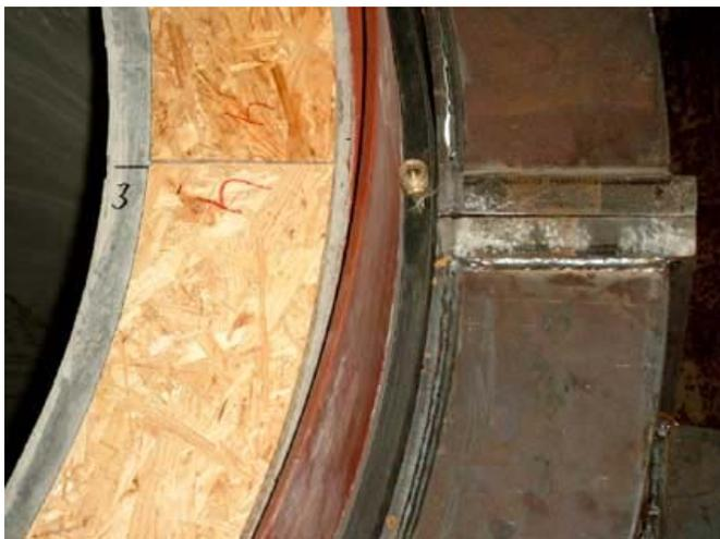
**Bild 99** Aufbau der Haltekonstruktion von Innen nach Außen: Rohrwand mit Druckübertragungsmittel / Druckkissen / Stahlring
