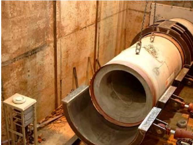
**Bild 98** Einlegen eines Vortriebsrohres in den Stahlring (mit Hydraulikkissen als Rohrbettung)
