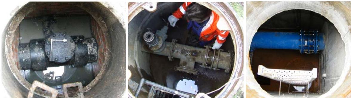
Abb. 3: Revisionsöffnung (li), T-Stück und Spülstutzen (mi) und Passstück (re) in Gussleitungen
