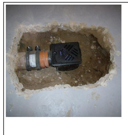
Abb. 23: Austausch Bodenablauf
