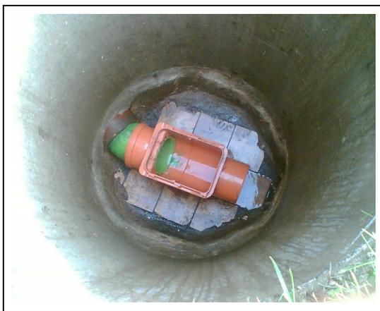
Abb. 26: Einbau Revisionsöffnung mit Inliner
