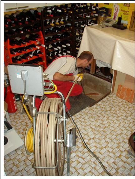
Abb. 6: Inspektion von Revisionsöffnung
