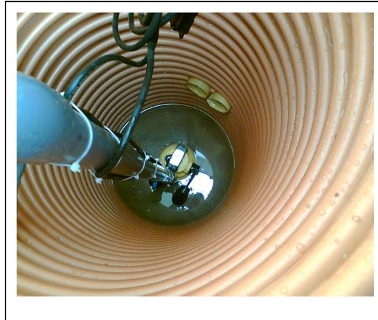
Abb. 29: Drainagepumpenschacht
