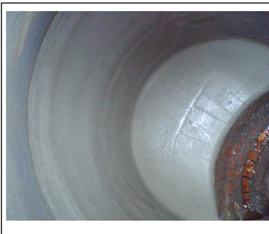
Abb. 30: Beschichteter Schacht
