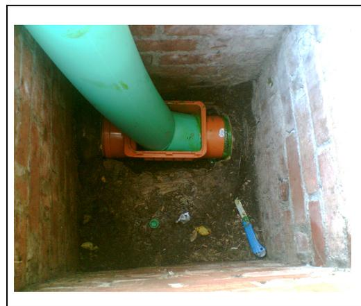
Abb. 27: Einbau Revisionsöffn. per Inliner
