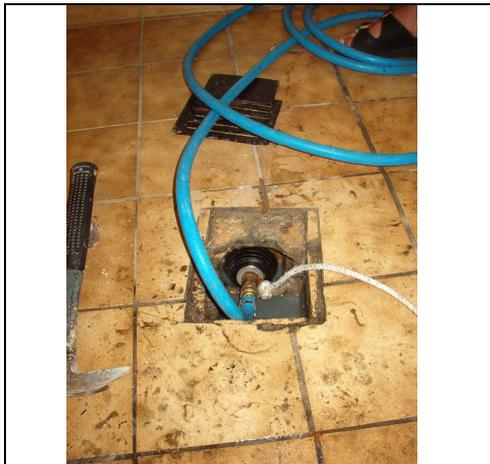
Abb. 38: abgesperrter Bodenablauf
