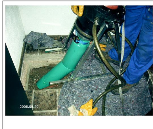
Abb. 33: Inlinereinbau aus Keller
