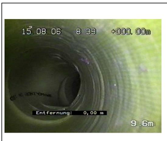
Abb. 34: Schlauchinliner im Bereich Bogen
