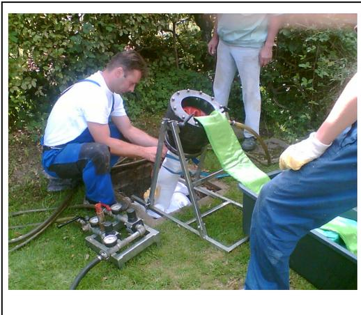
Abb. 32: Inlinereinbau durch Schacht
