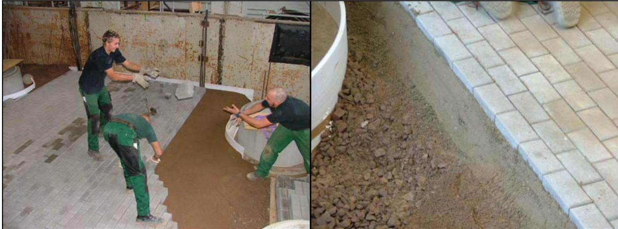
a) Verlegen der Pflastersteine im Läuferverband
