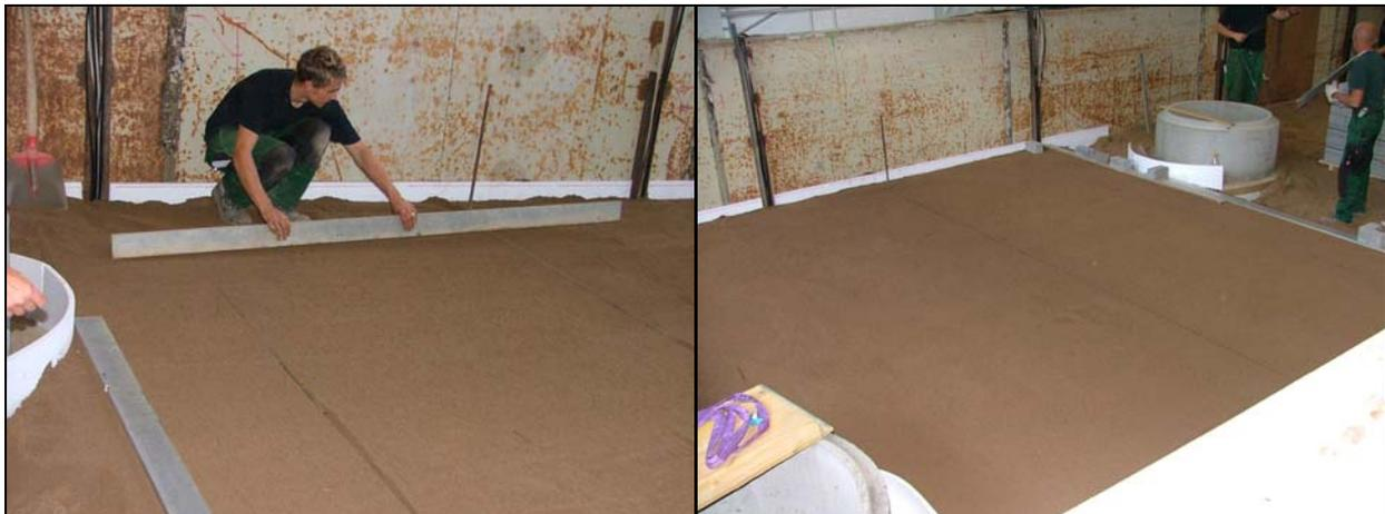
a) Abziehen der Fläche mit einer Wasserwaage
