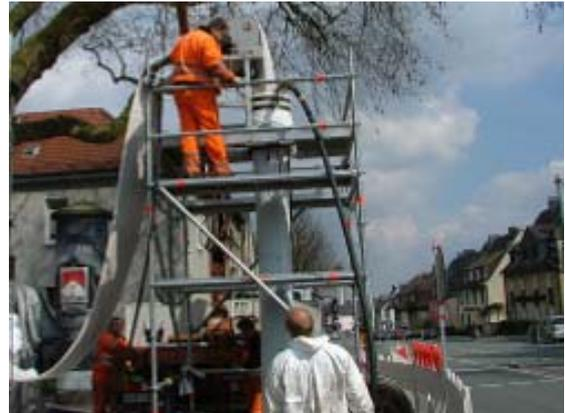
b) Inversion eines Schlauchliners, Beispiel Insituform-Liner (NF-UP)
