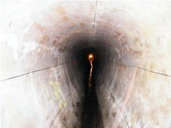
a) Messkabel in den sechs Querschnittspositionen
