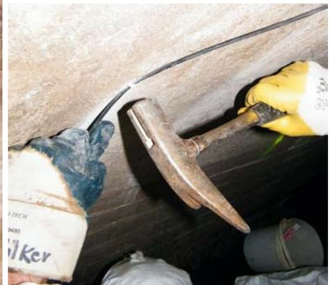
d) Befestigung eines Messkabels an der Altrohrwand
