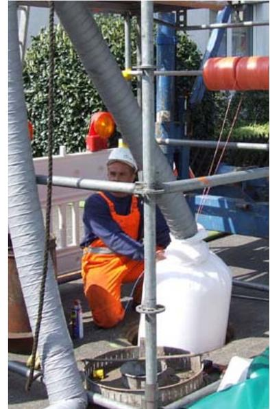
Abb. 39: Einbau des Preliners und der Hilfsseile
