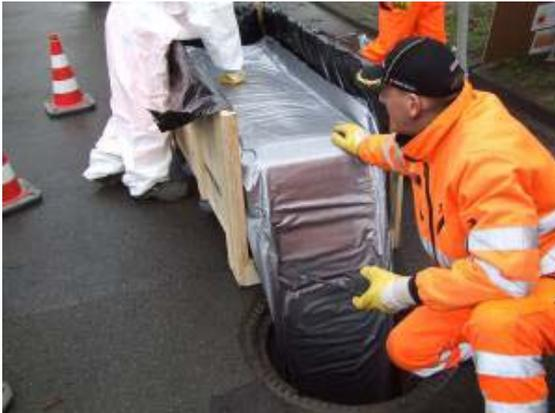
a) Einziehen eines Schlauchliners, Beispiel Brandenburger-Liner (GFK-UP)
