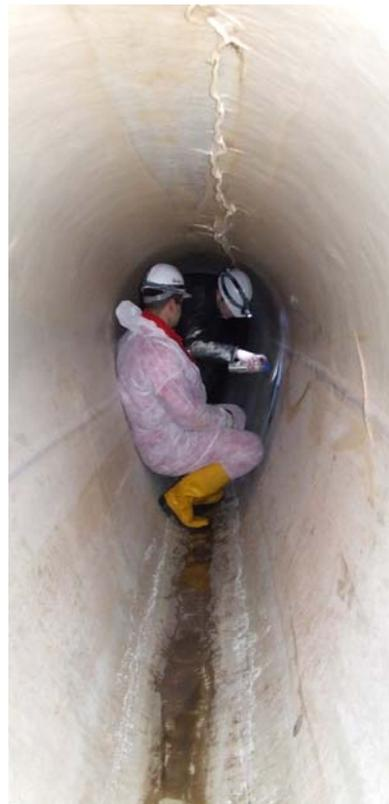
c) Markierung der Stationspunkte im Kanal
