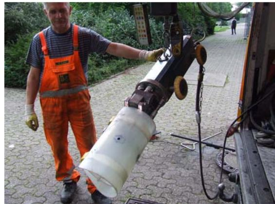
b) Schalungselement auf dem Kanalroboter, Vorbereitung der Reparatur
