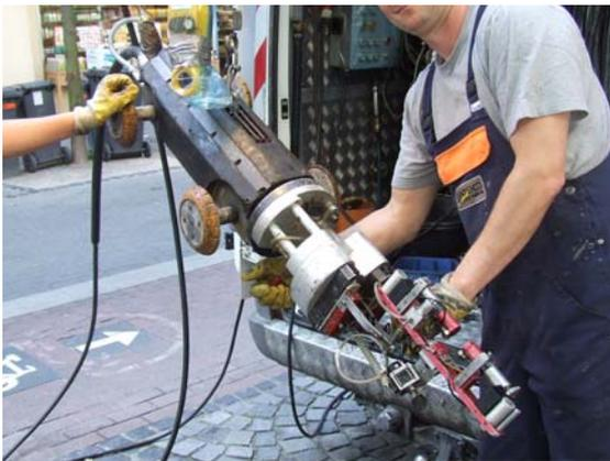
a) Vorbereitung des Kanalroboters zum Setzen des Schalungselementes
