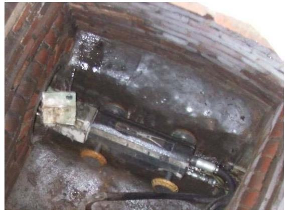
d) Kanalroboter im Einsatz, Bergung einer Materialprobe aus dem Schacht
