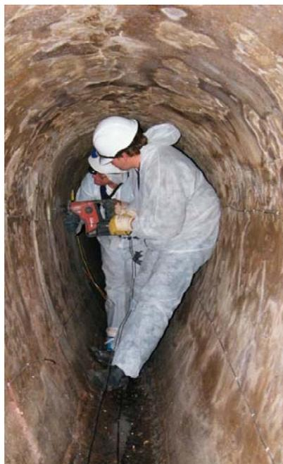
c) Bohren von Löchern in die Altrohrwand
