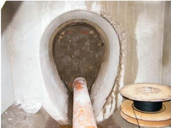
c) Abmauerung des zulaufenden Kanals im Startschacht
