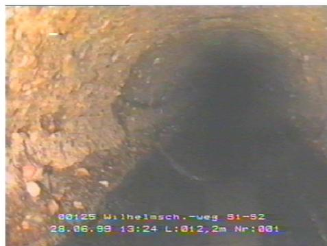
Abb. 82: Örtliche Vorverformung
