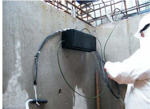
b) Anschluss der Messkabel an eine Wandmuffe im Startschacht
