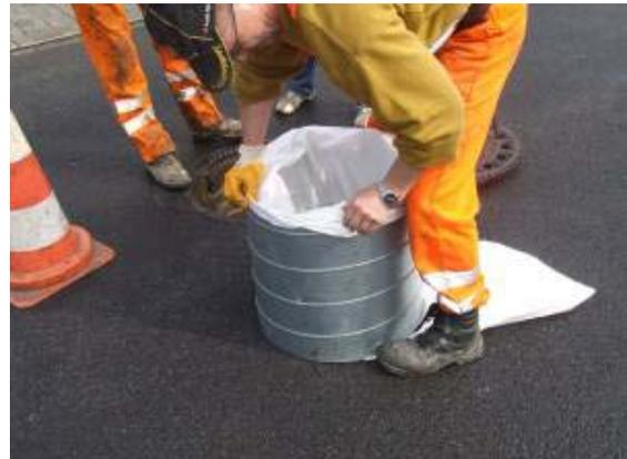
d) Vorbereitung des Stützkörpers zur Entnahme einer Schachtprobe
