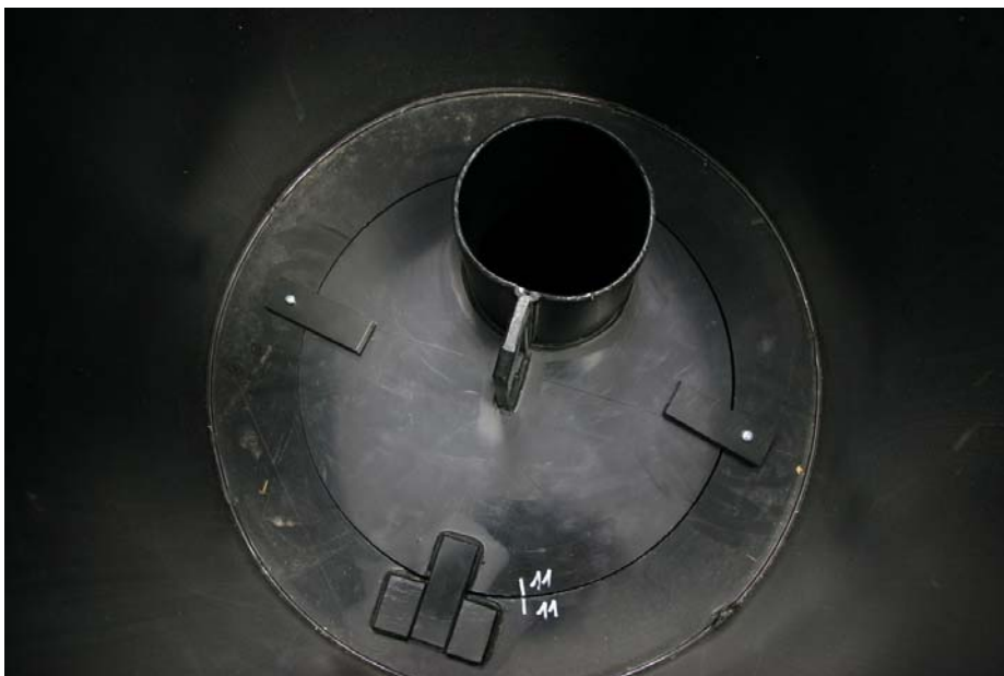
Abbildung 32: Blick in das Centrifloel-System mit eingesetzter Kreisschale des Nassschlammfangs und neuer Arretiervorrichtung
