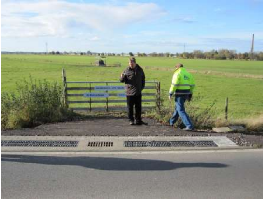
Abb. 1: Prüfstrecke an der L 875, Bildmitte: Einlauf für unbehandeltes Straßenabfluss-wasser
