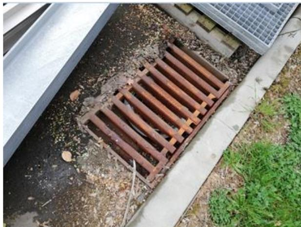
Bild 3-16: Straßenablauf mit nicht fertig asphaltiertem Belag
