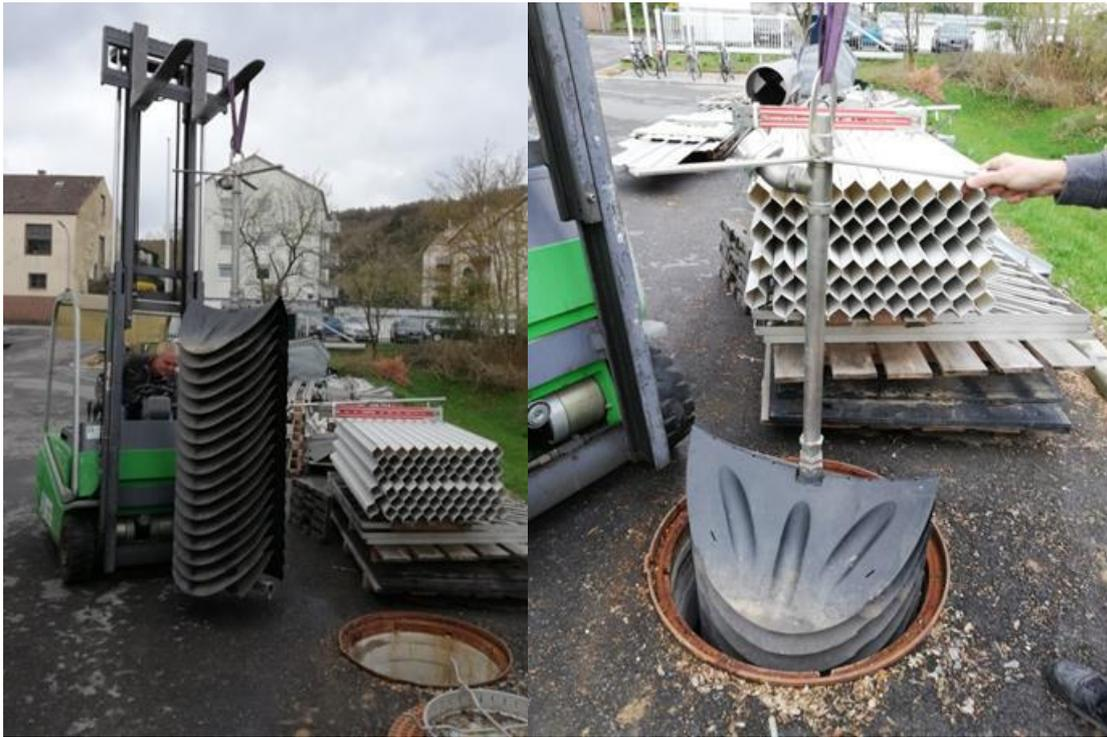
Bild 3-15: Einsetzen des Lamellenbaums
