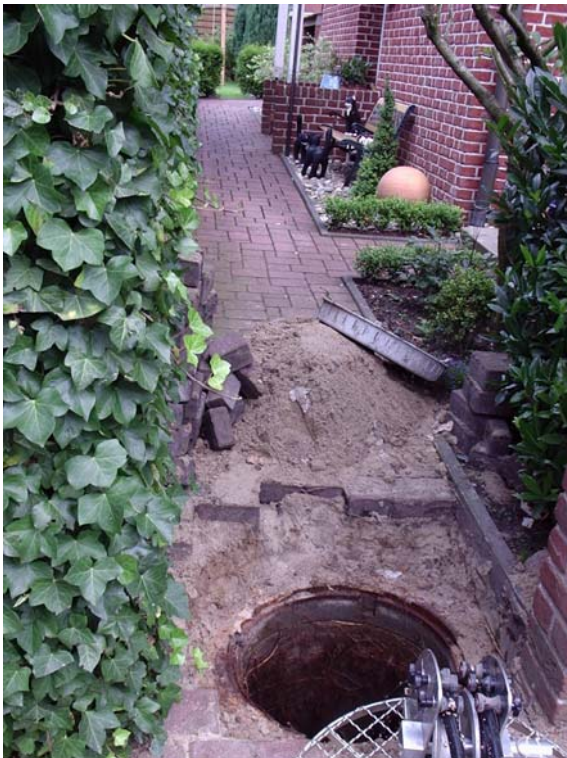
Abbildung 6: freigelegter Revisionsschacht
