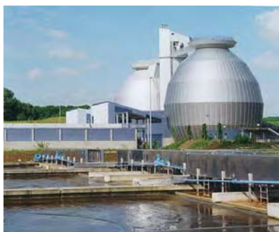
Abb. 6.14-1: Faulbehälter der KA Bochum Ölbachtal
