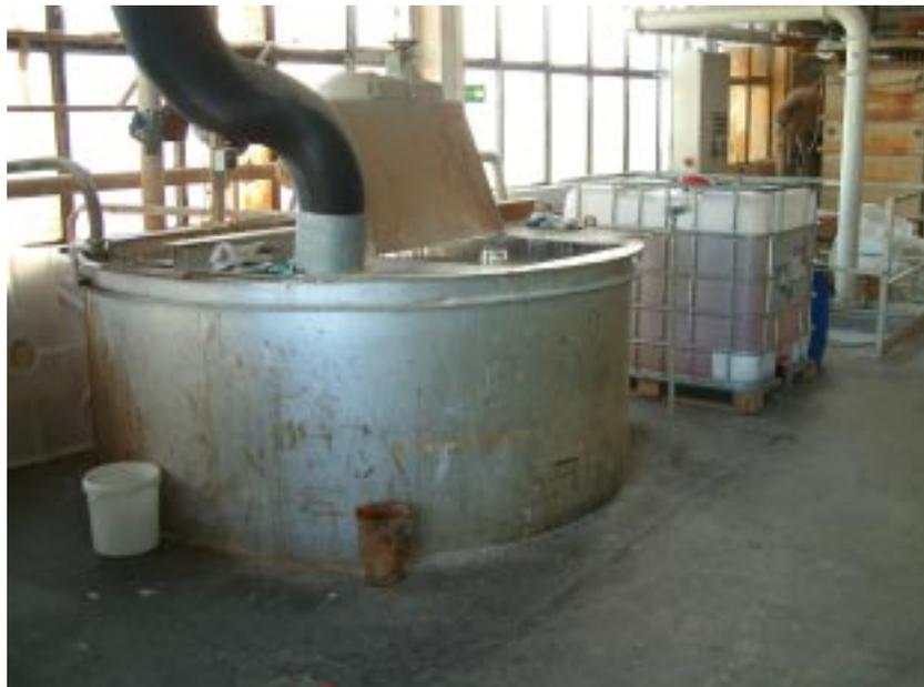
Foto 3: Rohabwasser-Vorlagebehälter  $RB_{1/2}$  mit PAC-Behälter (manuelle Zugabe durch Öffnung)
