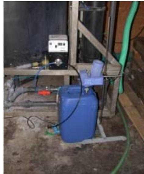
**Foto 9:** Entschäumerdosierstation
