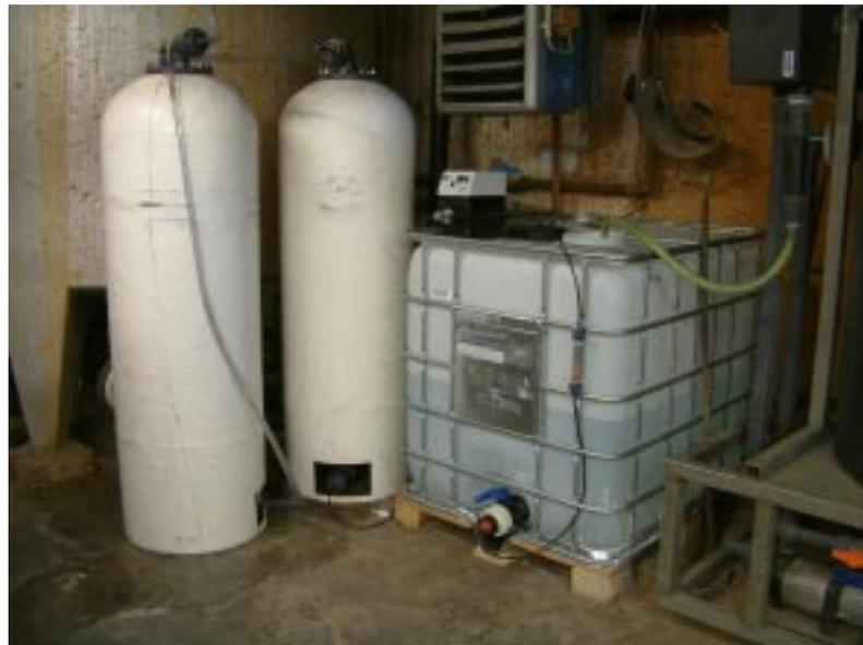
**Foto 10:** Pufferbehälter PB<sub>2</sub> mit Beschickungspumpe P<sub>3</sub>, Durchflussmessgerat DM<sub>3</sub> und Aktivkohlefiltern AK<sub>1/2</sub>
