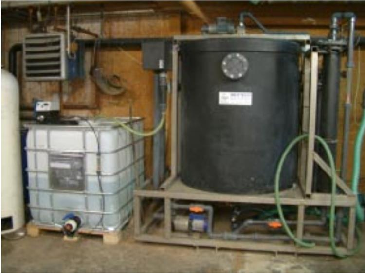
**Foto 8:** Flotationsanlage mit Pufferbehälter PB<sub>2</sub>
