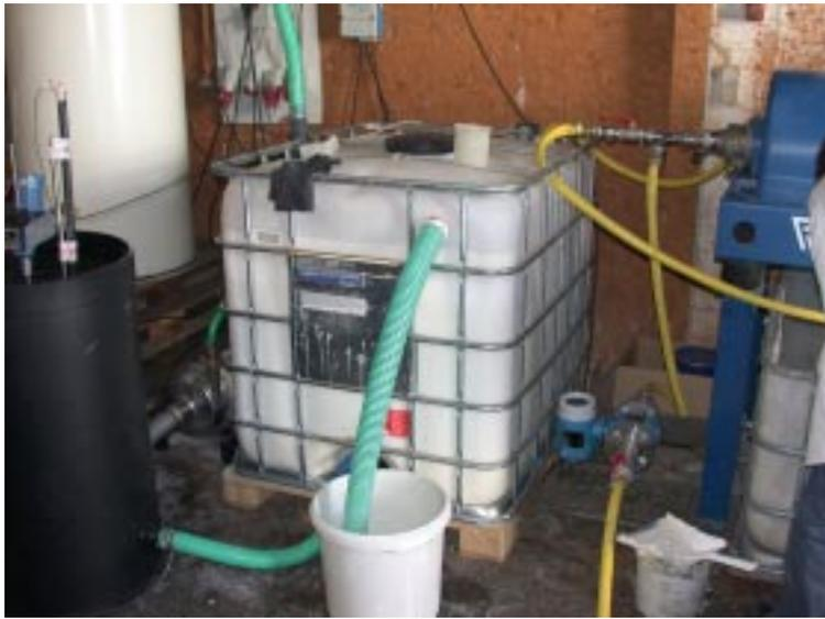
**Foto 11:** Pufferbehälter PB<sub>1</sub> mit nachträglich installiertem Schaumablass
