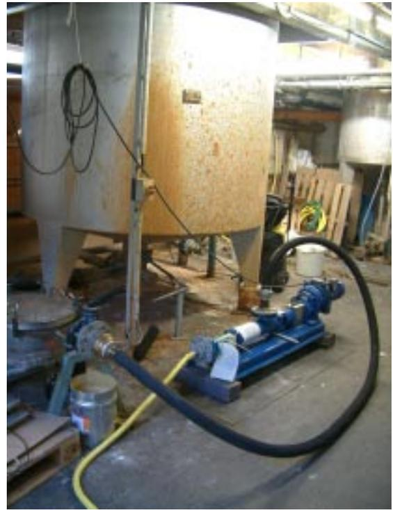
Foto 1 + 2: Rohabwasser-Vorlagebehälter  $RB_{1/2}$  mit Beschickungspumpe  $P_1$
