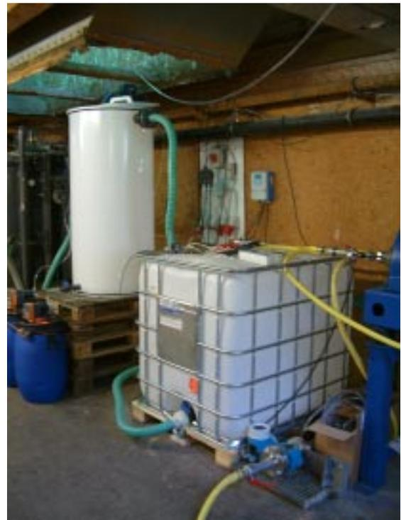
**Foto 5:** Pufferbehälter PB<sub>1</sub> (Zentratauffangbehälter), Durchflussmengenmesser DM<sub>1</sub> und pH-Steuerung
