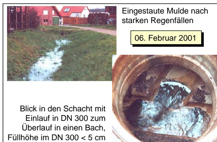
**Bild 4.7:** Einstauhöhen am MQ 1 und am Überlauf nach einem Starkregen
