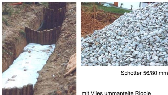
**Bild 2.6:** Einbau einer Rigole
