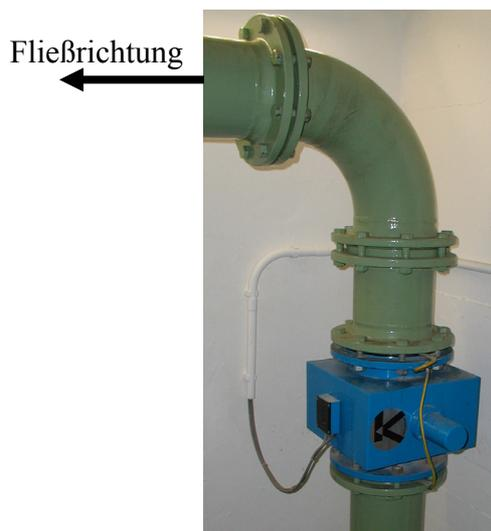
Bild 4-2: MID für die Zulaufmessung des Trockenwetterzuflusses
