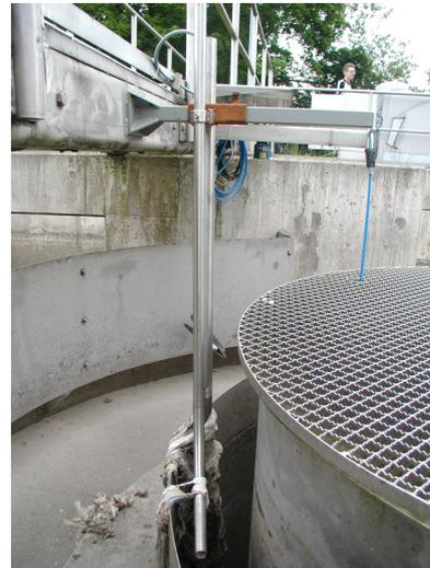
Bild 4-13: Halterung des Probenehmerschlauches am Überlauf des WA
