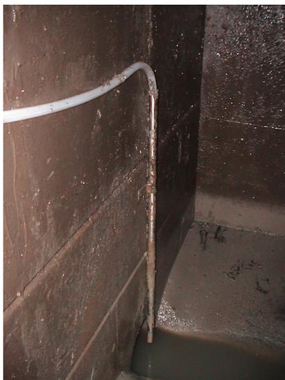
Bild 4-14: Halterung des Probenehmerschlauches an der Drossel des WA
