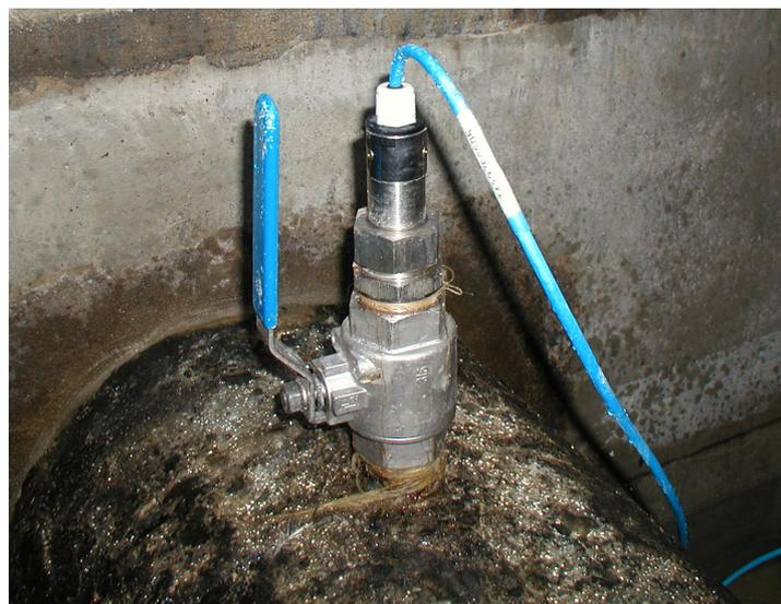
Bild 4-3: Ultraschall-Doppler-Sonde für die Zulaufmessung des Trockenwetterzuflusses
