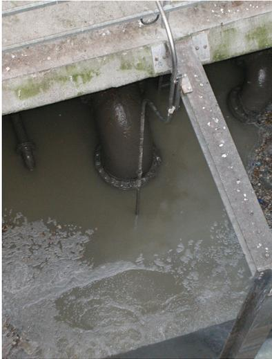
Bild 4-12: Halterung des Probenehmerschlauches im Pumpensumpf der TW- und RW-Pumpen
