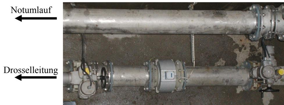
Bild 4-6: Drosselstrecke zur Kläranlage
