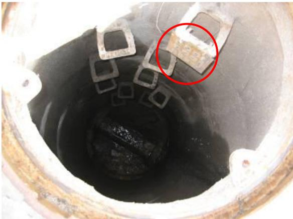
**Bild 4.25: PU Schild am ersten Steigeisen**
