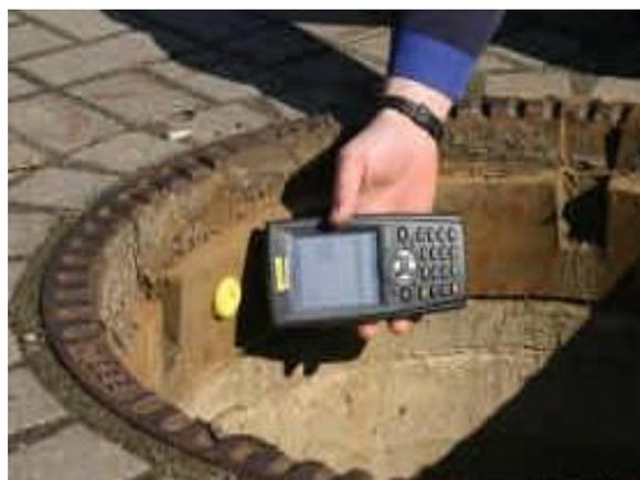
**Bild 4.22: Einlesen vom Transponder mit einem integrierten Lesegerät (TECTUS, 2011)**
