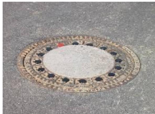
Bild 4.28: Pfropfen als Verschluss für Schachtabdeckungen (MH-Vertrieb, 2011)
